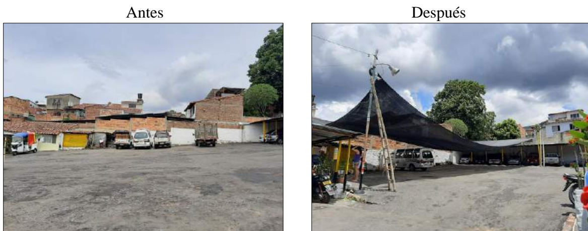
Figura 33. Instalación de polisombra en Parqueadero El Volante
