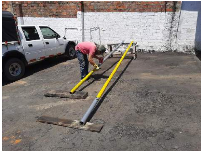
Figura 28. Instalación tubos de perforación
