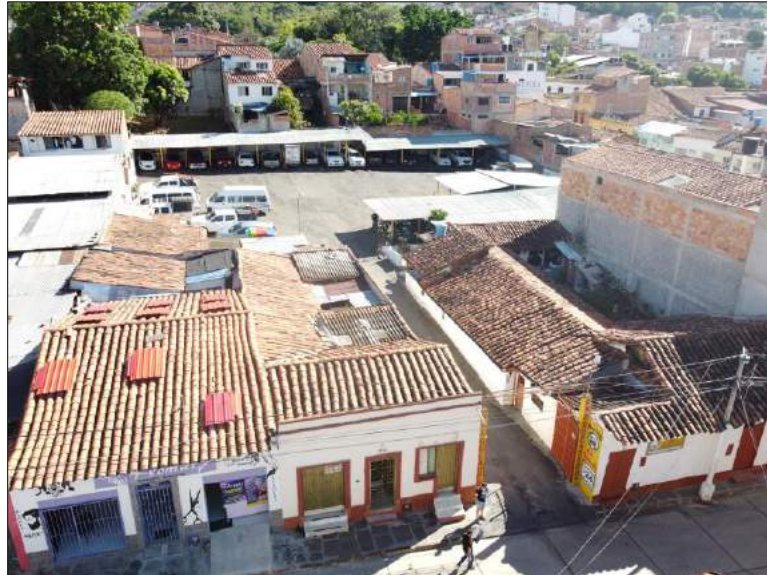
Figura 45. Vista aérea Parqueadero El Volante
