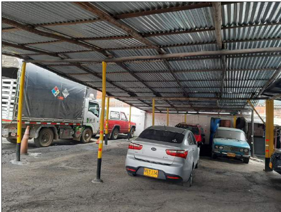
Figura 24. Techos Parqueadero El Volante
