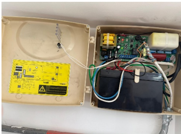
Figura 6.4: Trabajo realizado sobre la estructura perimetral y los conductores energizados del sistema.
