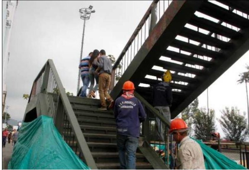
Ilustración 22. Mantenimiento puente peatonal
