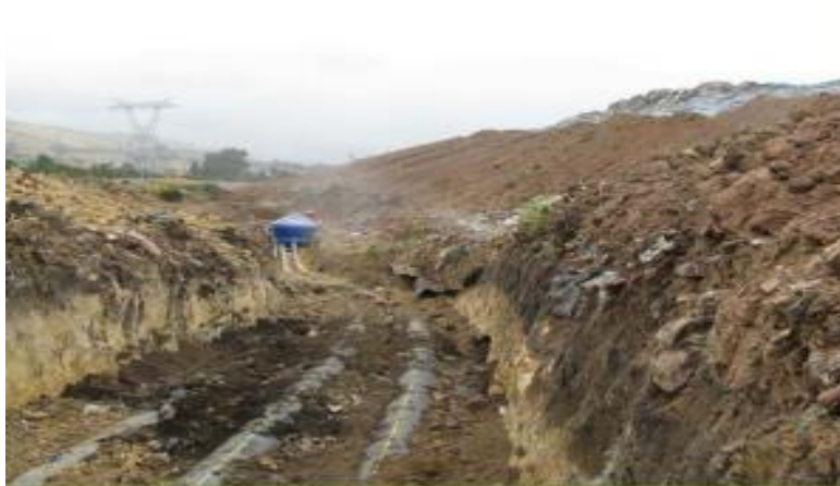
Figura 12. Redes para relleno sanitario
