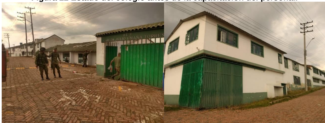
Figura 22 Estado del colegio antes de la capacitación del personal.
