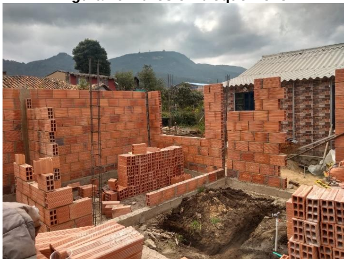
Figura 19 Muros en bloque No. 5.
