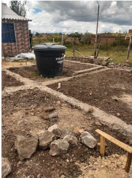
Figura 18 Cimentación en concreto ciclópeo.
