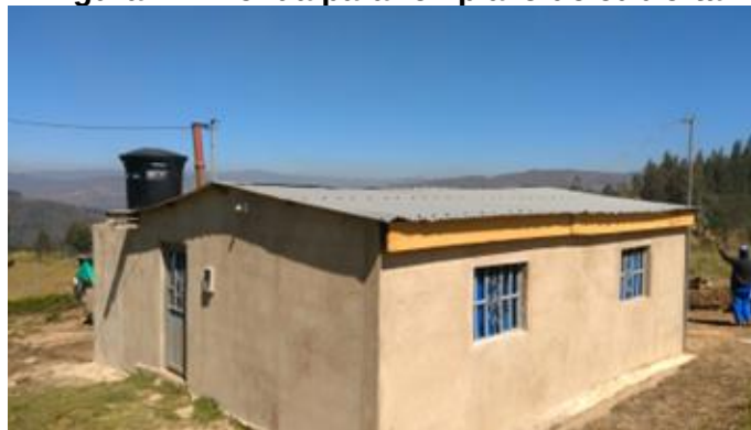
Figura 4 Vivienda para remplazo de cubierta
