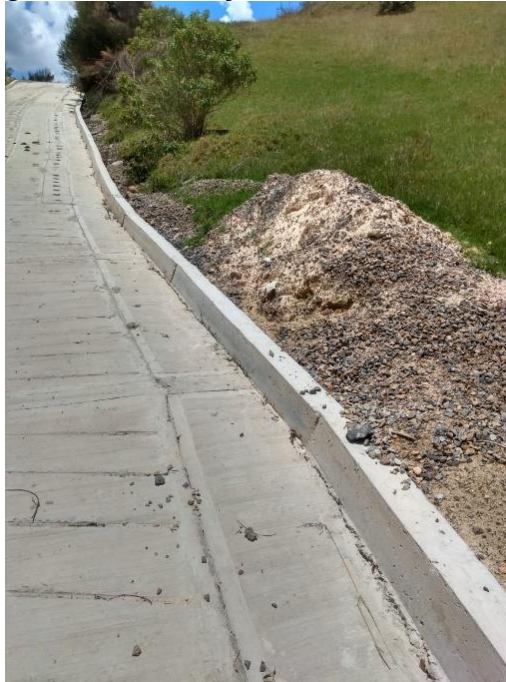
Figura 8 Cunetas y Bordillos terminados
