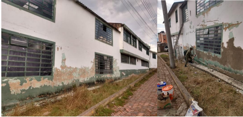
Figura 23 Estado inicial de la fachada y trabajos de reparación.
