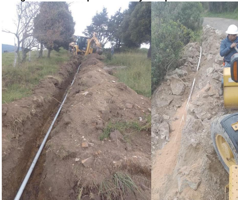
Figura 13 Relleno para la base y atraque de la tubería
