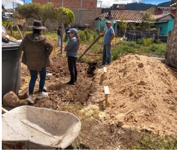
Figura 17 Excavación para cimentación.
