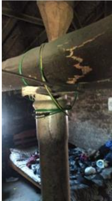
Figura 2 Estado inicial de la cubierta
