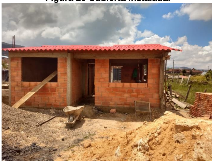
Figura 20 Cubierta instalada.
