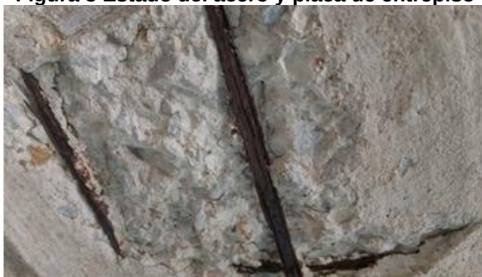
Figura 5 Estado del acero y placa de entepiso
