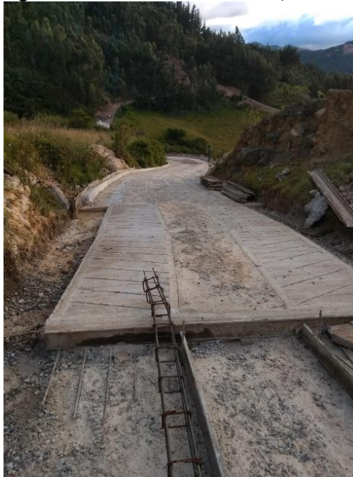
Figura 6 Concreto Hidráulico, tramo 2
