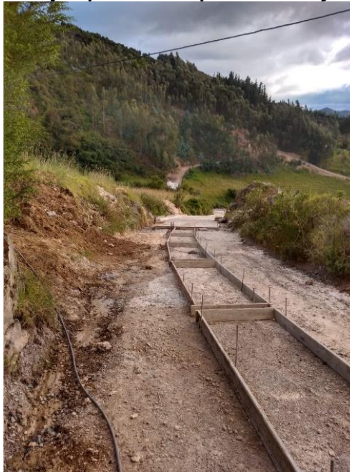
Figura 7 Cajón para fundir placa huella y ciclópeo
