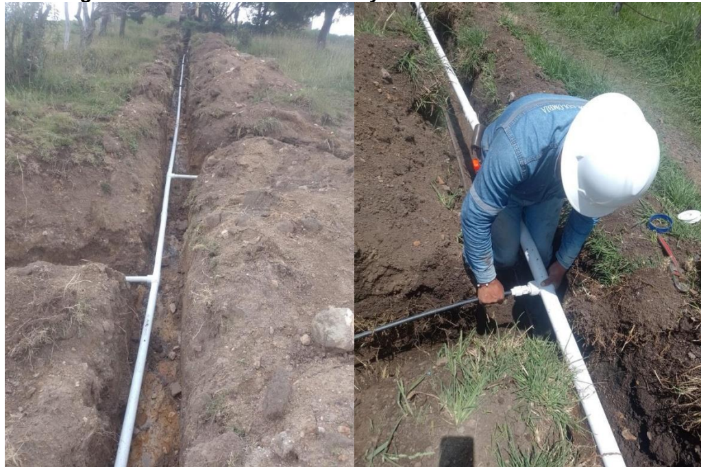
Figura 12 Instalación de tubería y distribución a beneficiarios
