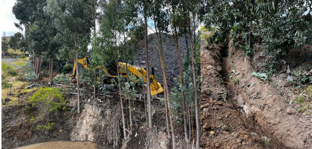
Figura 11 Excavación mecánica para red de Acueducto
