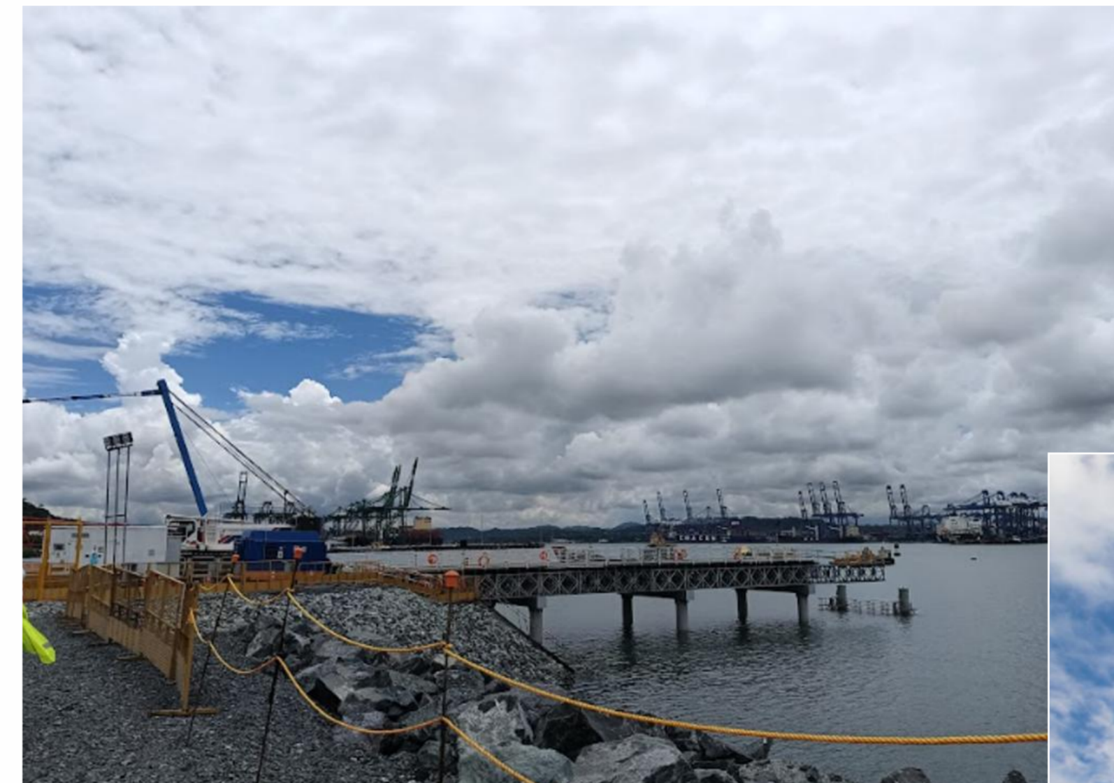
CUARTO PUENTE – PANAMÁ
