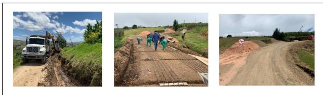
Figura 10. Visita para verificación de armado de testero, tramo de vereda Tocavita
