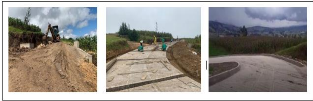
Figura 9. Proceso tramo vereda Tocavita
