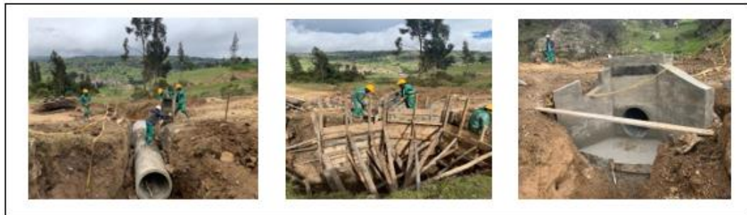
Figura 22. Actividades realizadas en el tramo de vereda Guaticha: fundida de concretos
