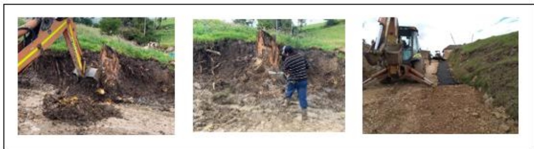
Figura 16. Actividades realizadas en el tramo de la vereda Siachoque Arriba: ampliación de la cuneta
