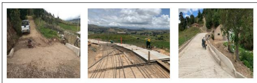
Figura 24. Proceso del tramo vereda Firaya
