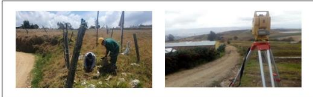
Figura 3. Actividades previas a la apertura de las obras
