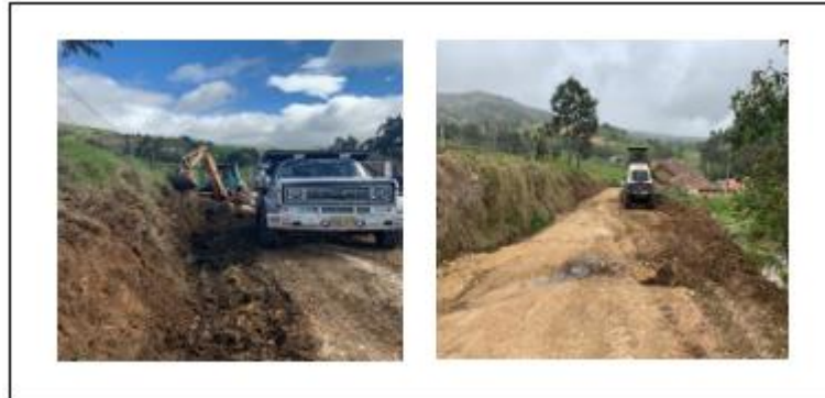
Figura 27. Verificaciones hechas durante la visita a Siachoque Abajo
