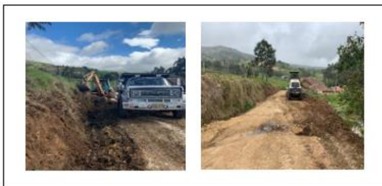
Figura 19. Verificaciones hechas durante la visita a Siachoque Abajo
