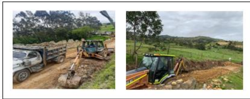
Figura 25. Actividades realizadas en el tramo de la vereda Firaya: limpieza de cunetas
