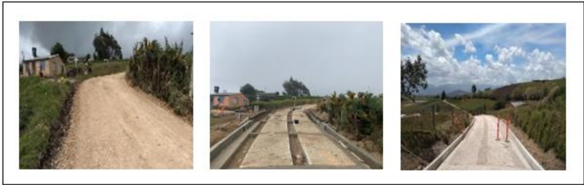
Figura 12. Proceso del tramo vereda Cormechoque Arriba
