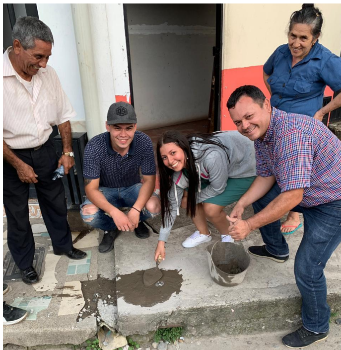
Figura 22. Registro fotográfico de la instalación de la placa número 2 con el acompañamiento y la ayuda de algunos habitantes del barrio Montecarlo Fuente: Autores.
