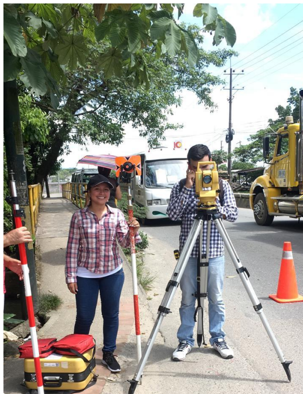
Figura 12. Medidas de seguridad durante levantamiento topográfico en campo Fuente: Autores.
