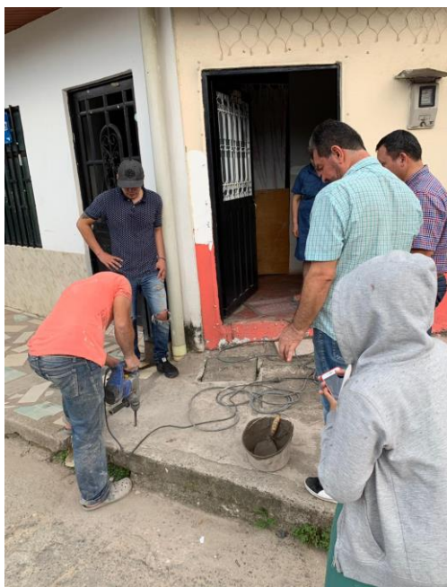
Figura 19. Registro fotográfico de la perforación para la instalación de la placa número 2 Fuente: Autores.
