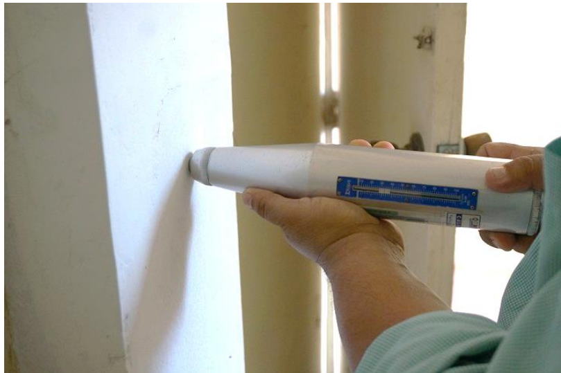
Imagen 55. Detalle Esclerometría columnas. 3er piso. Fuente: Autores.
