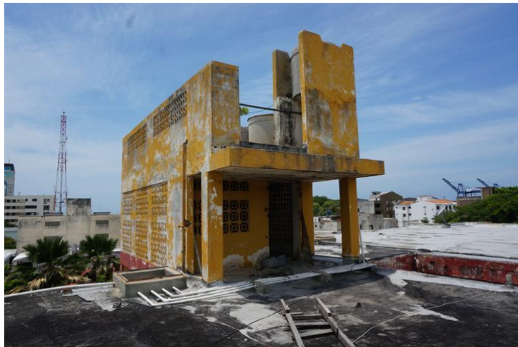
Imagen 31. Detalle de la estructura de soporte de los tanques elevados. Fuente: Autores.
