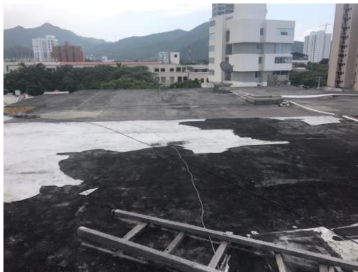
Imagen 7. Vista panorámica de la cubierta del edificio Santa Inés. Fuente: Autores.
