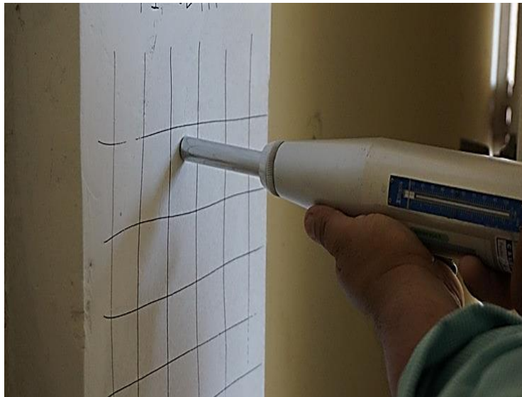
Imagen 47. Cumplimiento plan de Inspección. Realización ensayo Esclerometría, elementos estructurales.
