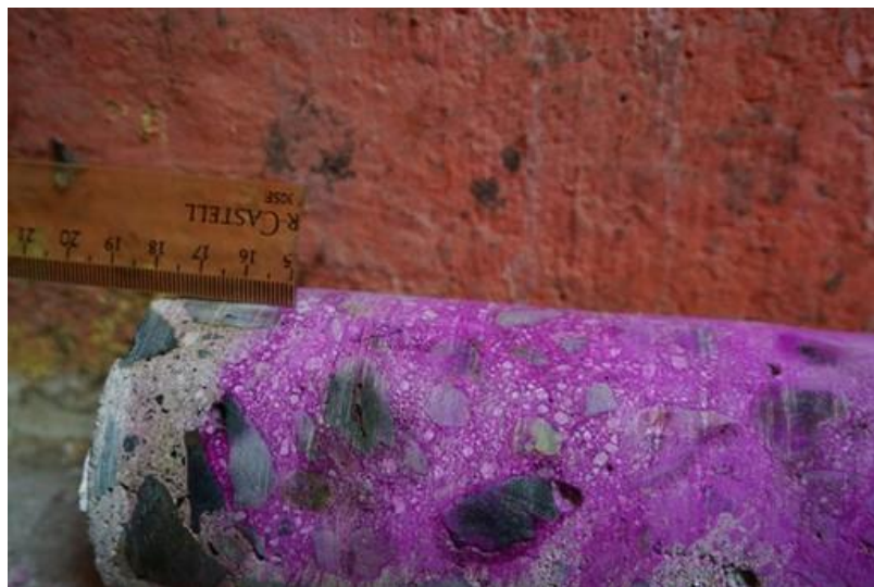
Imagen 58. Núcleo extraído. Evidencia de la profundidad de Carbonatación. Fuente: Autores.
