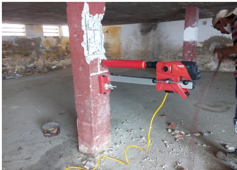
Imagen 49. Cumplimiento plan de Inspección. Realización inspección y medida del acero de refuerzo. Fuente: Autores.
