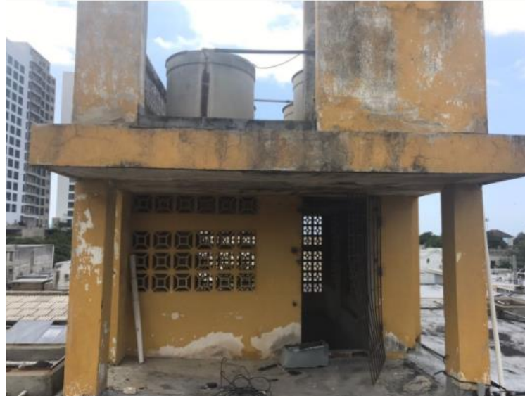
Imagen 8. Zona de tanques elevados de acopio de agua potable. Fuente: Autores.
