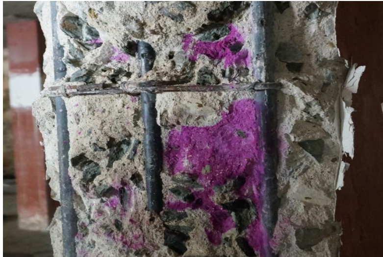
Imagen 48. Cumplimiento plan de Inspección. Realización ventana de inspección, prueba de carbonatación. Fuente: Autores.
