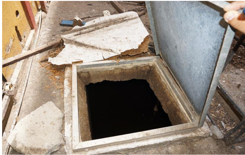
Imagen 29. Detalle Tapa del tanque.
