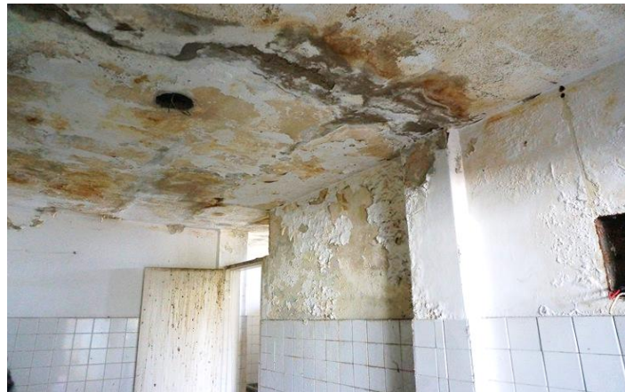
Imagen 34. Detalle la cubierta y la zona inferior (cielo raso).
