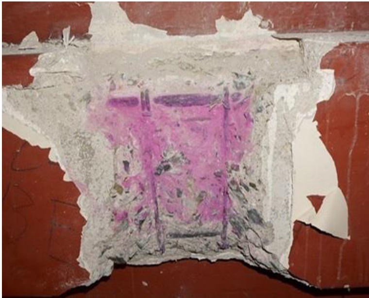
Imagen 56. Detalle realización de ensayo carbonatación Viga TERCER PISO TRAMO F2-F3 Fuente: Autores.
