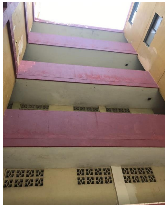
Imagen 39. Detalle de las fachadas internas.
