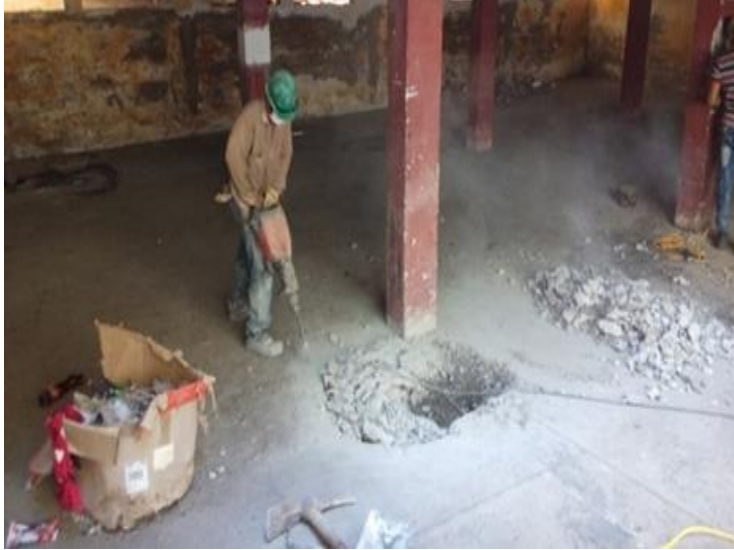
Imagen 26. Detalle de la exploración para la verificación de las cimentaciones. Fuente: Autores.
