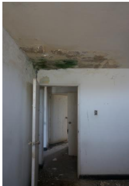
Imagen 6. Detalle estado interno apartamentos. 4to. Piso. Fuente: Autores.
