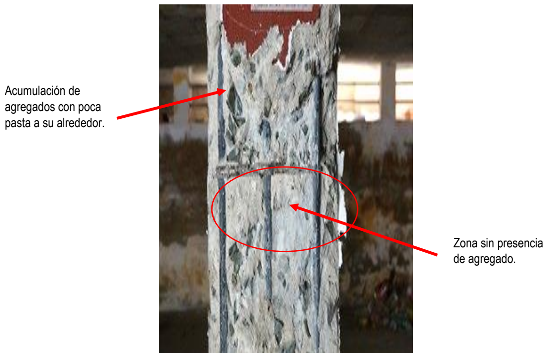
Imagen 24. Detalle de la disposición de los agregados en la columna. Fuente: Autor.
