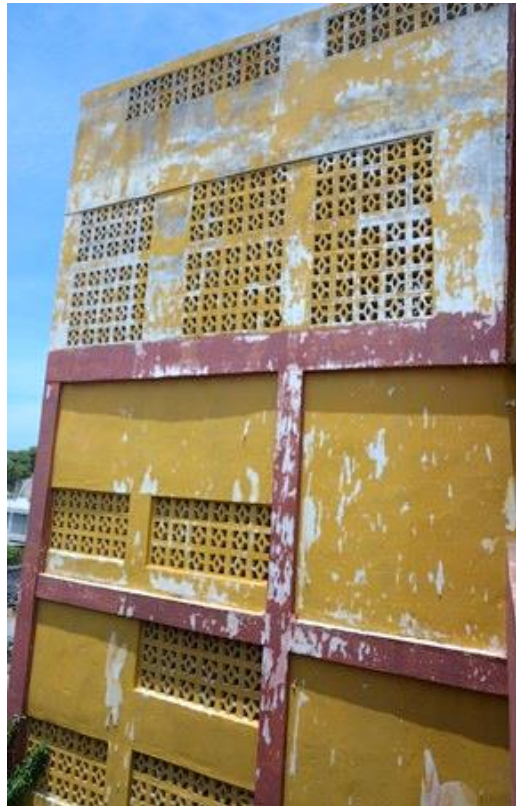
Imagen 21. Fachada Sur hacia el patio, detalle de los calados para ventilación. Fuente: Autores.
