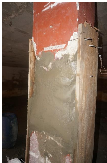
Imagen 15. Reparación de las columnas posterior a la exploración. Fuente: Autores.
