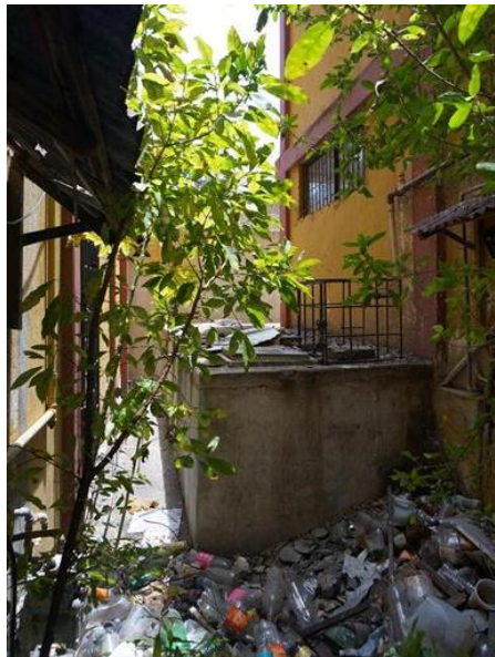
Imagen 28. Detalle de la ubicación del tanque en medio de un vacío generado por la irregularidad del edificio. Fuente: Autores.
