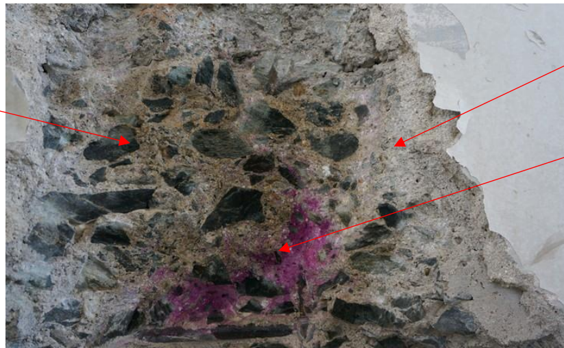
Imagen 59. Detalle de la medida de la carbonatación en la viga Tramo F2-F3. Se aprecia como un sector ya después del acero de refuerzo presenta sanidad. Fuente: Autores.
