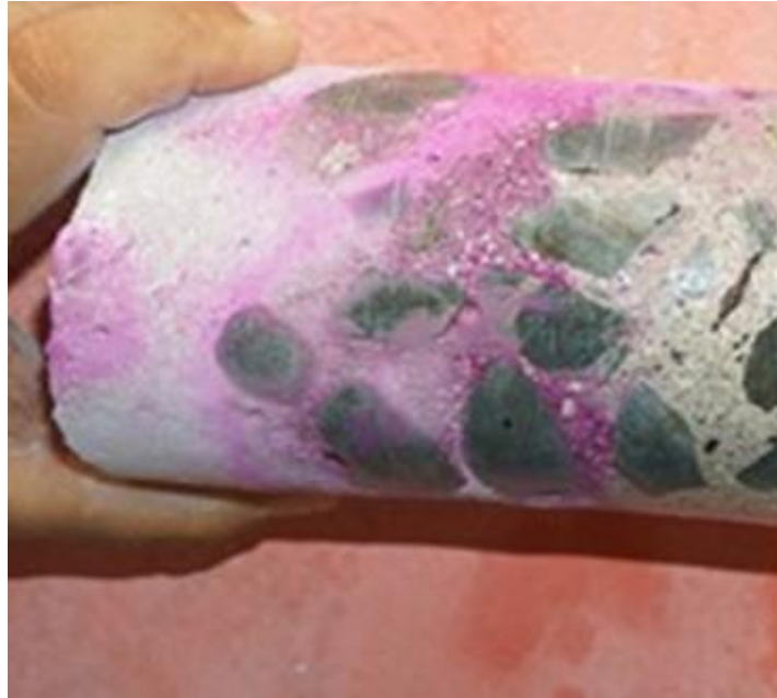
Imagen 57. Núcleo extraído columna I4. Evidencia de la profundidad de Carbonatación. Fuente: Autores.
