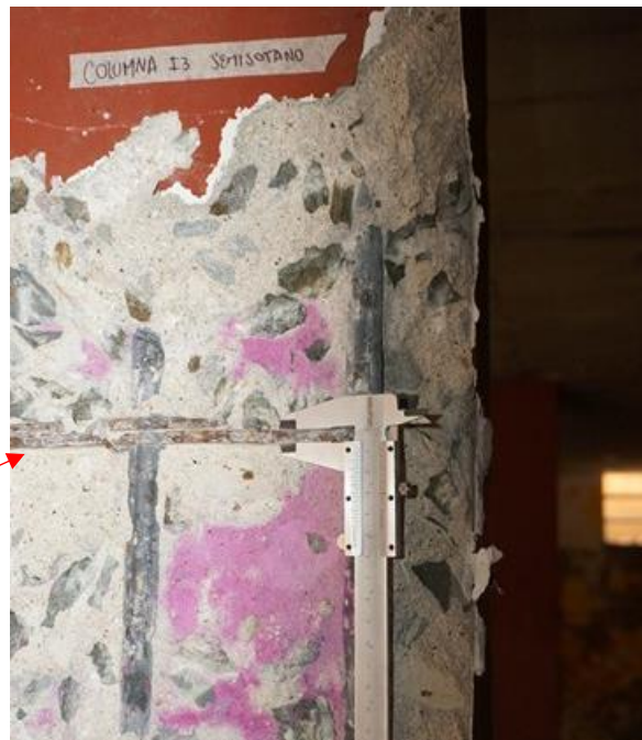
Imagen 53. Detalle medida de los espesores y estado de los aceros de refuerzo existentes. Columna I3 Fuente: Autores.
