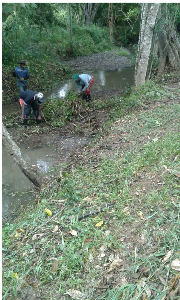
Limpieza de lecho
