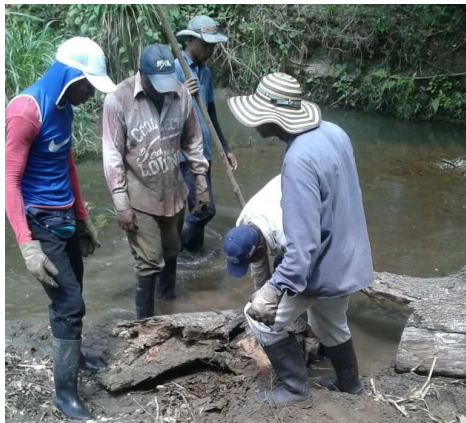
Retiro de material aprovechable
