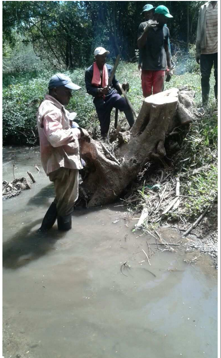
Retiro de material vegetal
