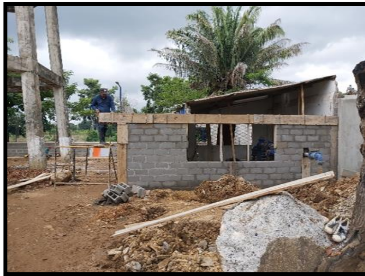
Figura 18. Construcción de estación de bombeo principal
