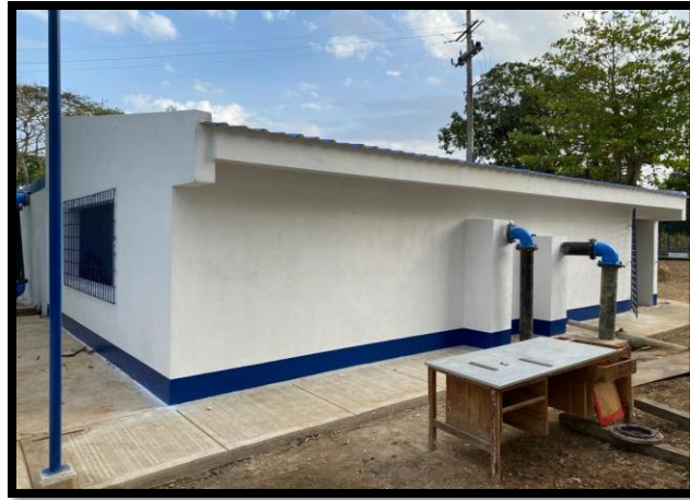
Figura 23. Estación de bombeo final
