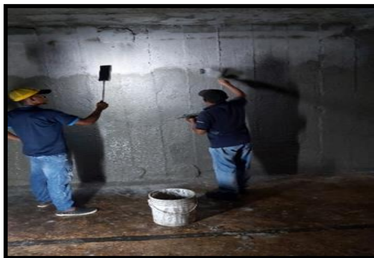
Figura 15. Impermeabilización de tanque recolector de agua
