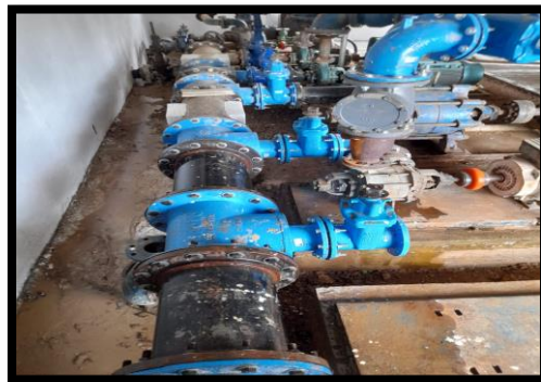
Figura 22. Unificación de estación de bombeo por medio de instalación e todos los motores
