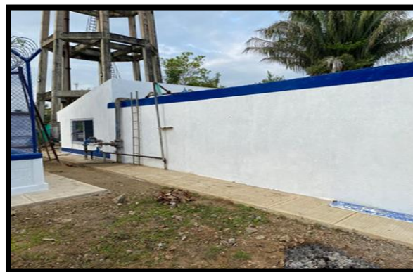
Figura 17. Impermeabilización de tanque recolector de agua
