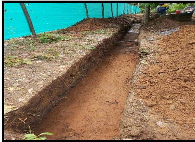
Figura 10. Excavación de zanjas para cerramientos
