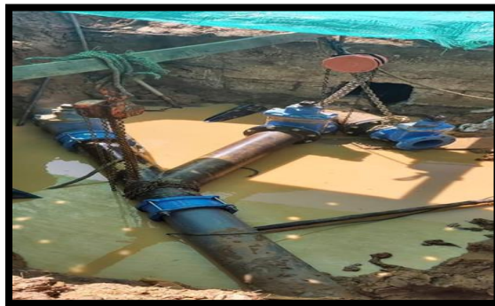
Figura 20. Empalme de tubería de impulsión
