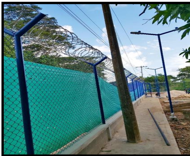
Figura 13. Cerramientos de seguridad en la estación de bombeo de Momil.
