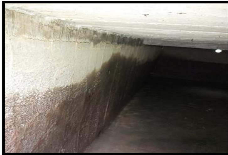
Figura 14. Tanque recolector de agua
