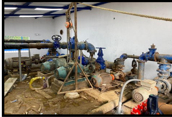
Figura 19. Galería de expulsión e impulsión, instalación de motores
