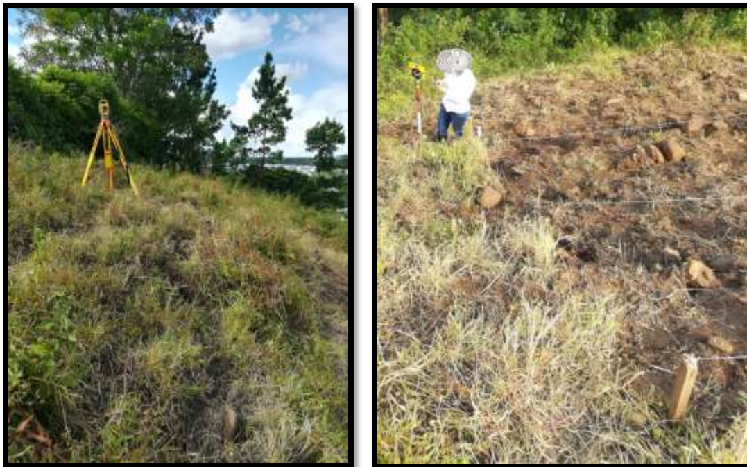
Figura 3-13. Estación topográfica y cadenero con prisma en el levantamiento. Fuente: Autor
