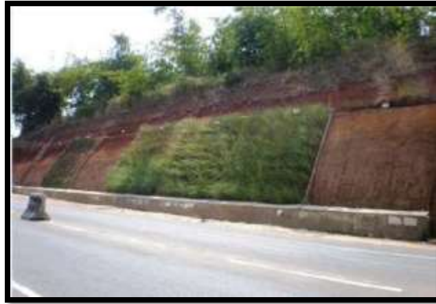
Figura 2-5 Comparación de tres tipos de densidades de Vetiver en West Java Indonesia. Fuente: Evaluación de parámetros de resistencia al corte en suelos de ladera cubiertos con Vetiver (2017).
