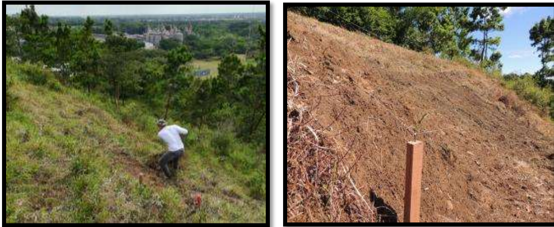
Figura 3-11. Limpieza y descapote del área de 100 m 2 . Fuente: Autor
