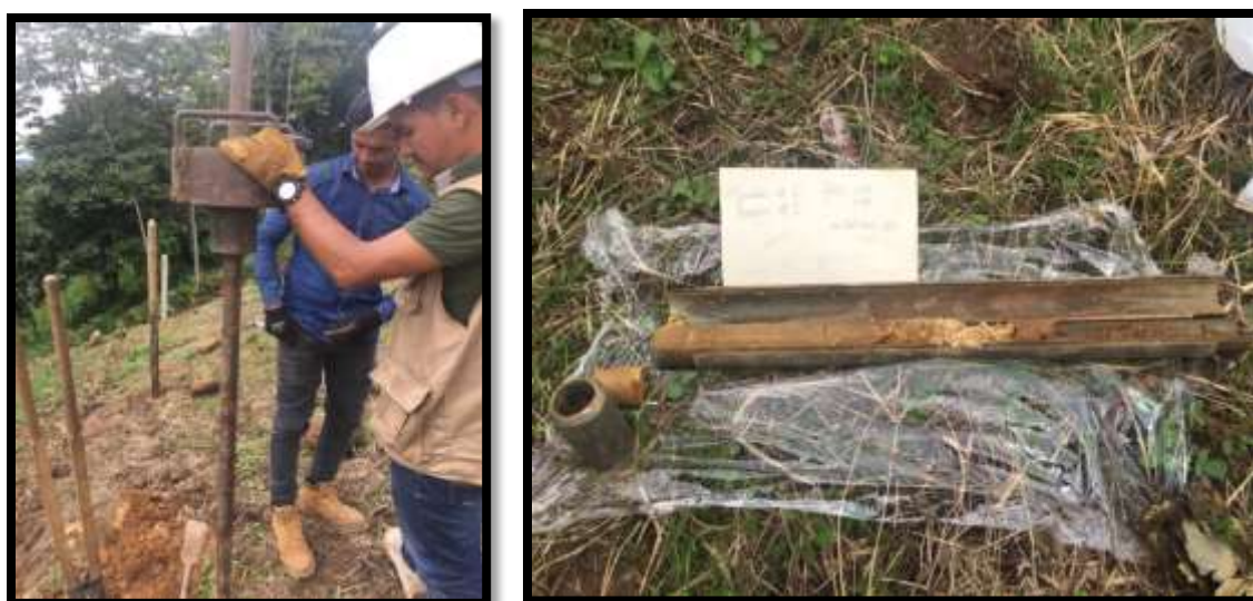
Figura 3-10. Ejecución del sondeo y toma de muestras. Fuente: Autor
