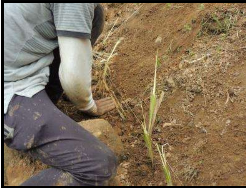
Figura 3-17. Siembra de las plántulas de Vetiver. Fuente: Autor
