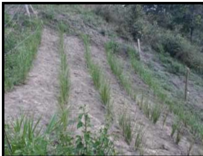
Figura 3-19. Estado actual del talud con Vetiver y Micorrizas 4 meses después.
