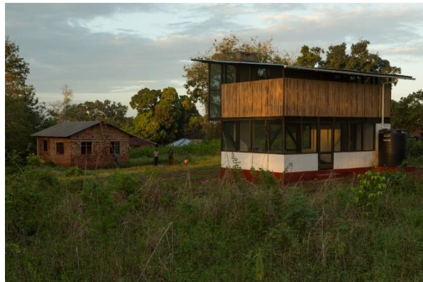
Figura 18. Casa Proyecto Magoda Fuente: Tomado de Archdaily Colombia
