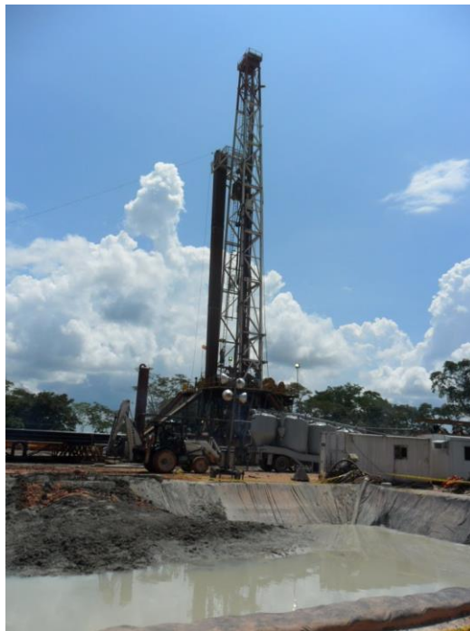
Figura 68. Perforación en estación petrolera Cantagallo Fuente: Mapio.net
