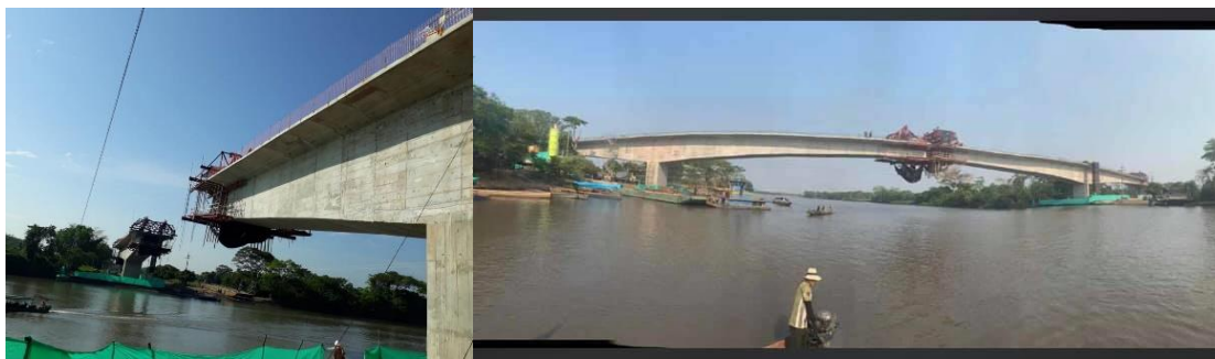
Figura 133. Puente Cimitarra Cantagallo-San Pablo sobre el Rio Cimitarra Fuente: Tomado de la página Transversal de las Américas
