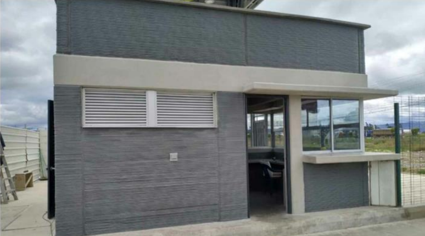
Imagen. Portería del parque industrial Logika Siberia, Cundinamarca. Fuente: Conconcreto.
