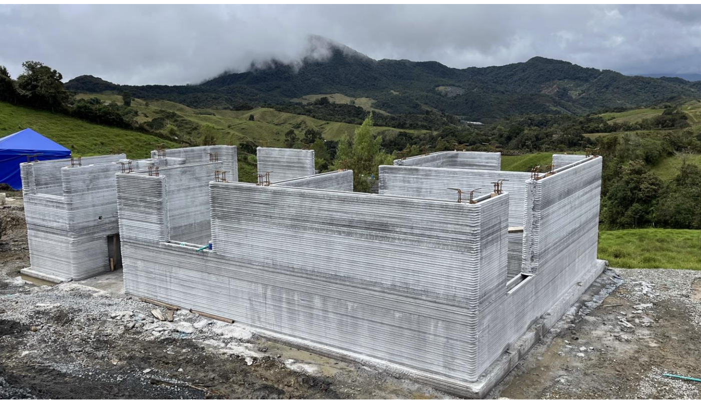
Imagen. Impresión 3D. Casa impresa en concreto en el municipio de La Unión, Antioquia. Fuente: Cementos Argos
