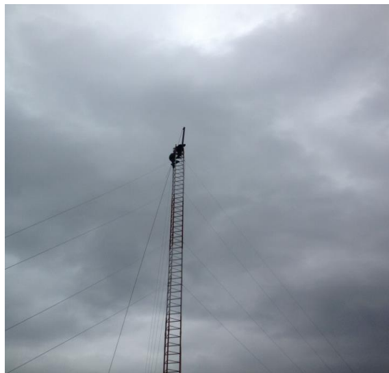
Figura 20. Finalización de la instalación, anclaje final.
