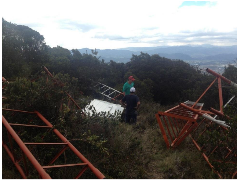
Figura 18. Instalación de base de la torre
