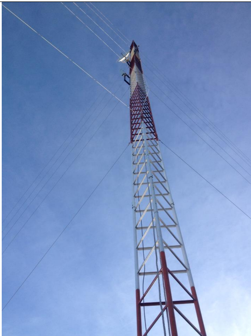
TORRE FINALIZADA CON RADIO TRONCAL INSTALADO
