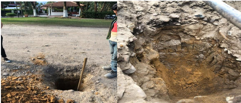
Figura 7. Apique K1+000 con profundidad de 1.50m
