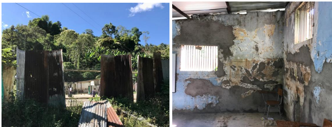
Figura 3. Condiciones actuales, cerramiento perimetral y aula de clases
