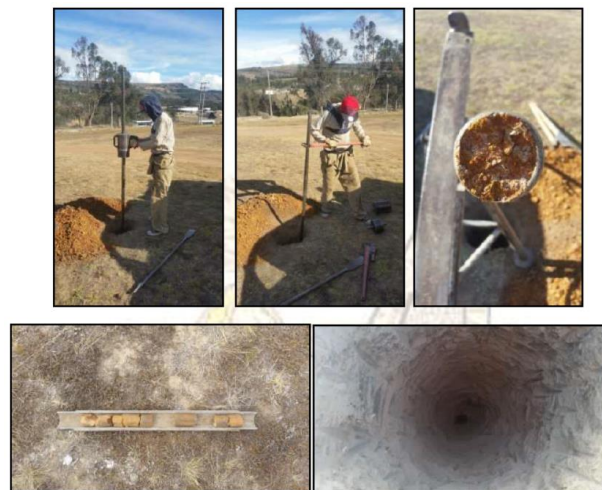
Figura 7. Ejecución de sondeos en el predio del proyecto, sondeo 3
