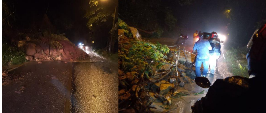
Figura 18. Movimiento en masa en la vía Piedecuesta-Mesa de los Santos 21-09-2022
