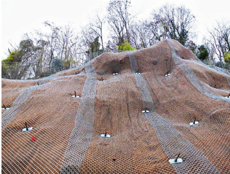
Figura 79. Mallas ancladas en taludes
