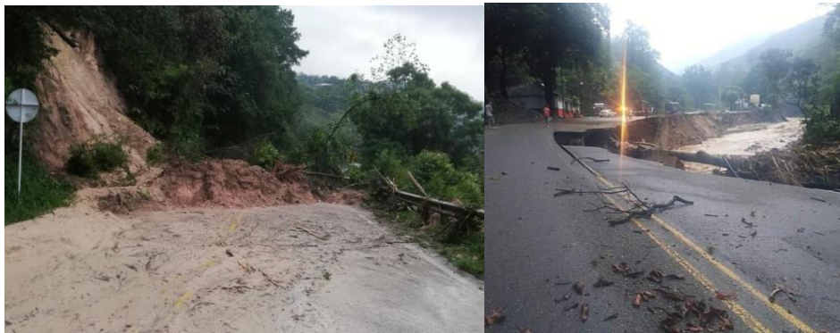
Figura 15. Deslizamiento del 26-02-2020 en la vía Piedecuesta-Mesa de Los Santos
