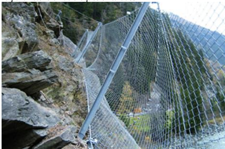
Figura 78. Malla para retención de bloques en taludes
