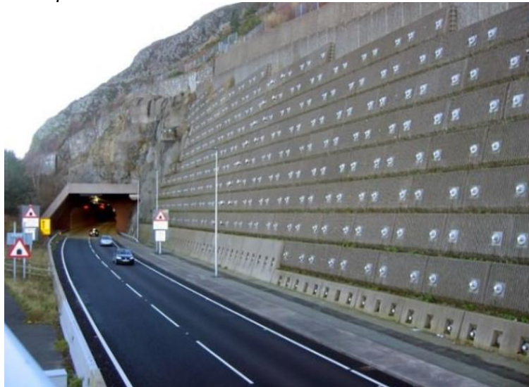
Figura 81. Cubiertas de protección en taludes
