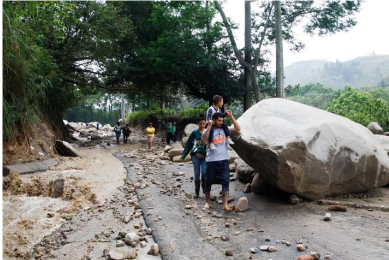
Figura 16. Deslizamiento de rocas vía Piedecuesta-Mesa de Los Santos 27-02-2020
