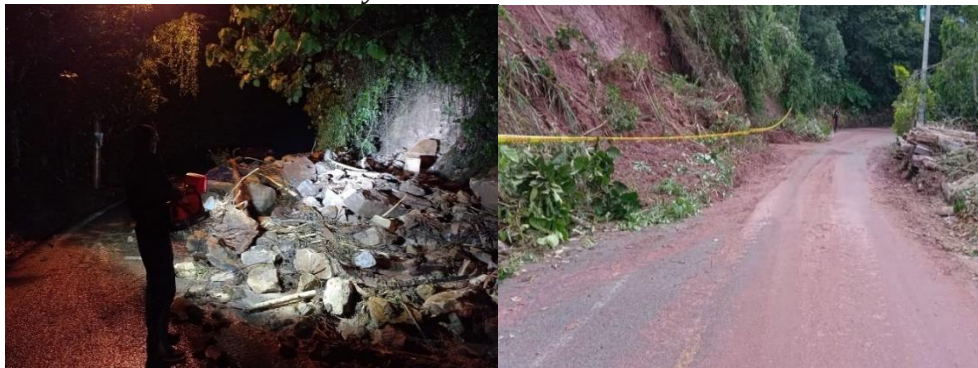
Figura 17. Derrumbe del 01-03-2022 y 04-04-2022 en la vía Piedecuesta-Mesa de Los Santos
