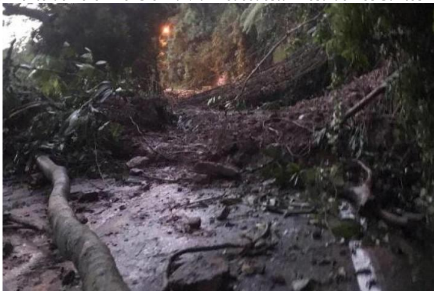
Figura 19. Deslizamiento de 16-04-2023 en la vía Piedecuesta-Mesa de Los Santos
