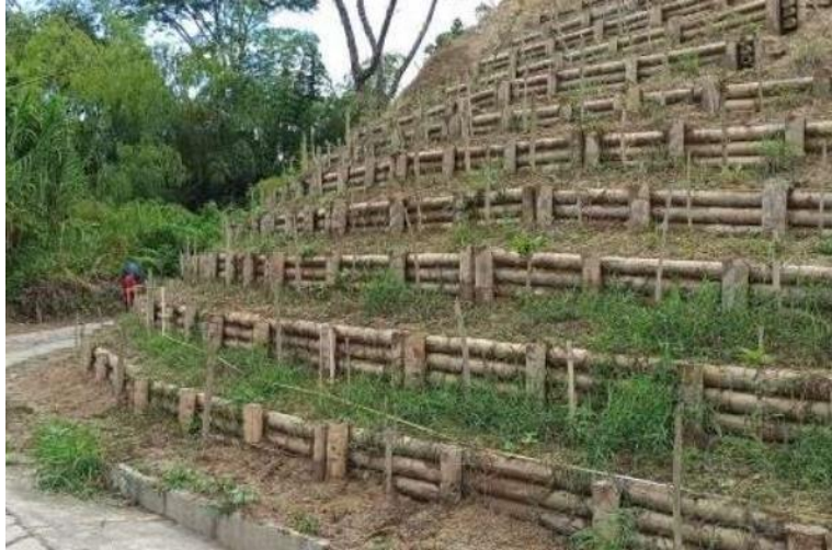
Figura 77. Trincheras en taludes
