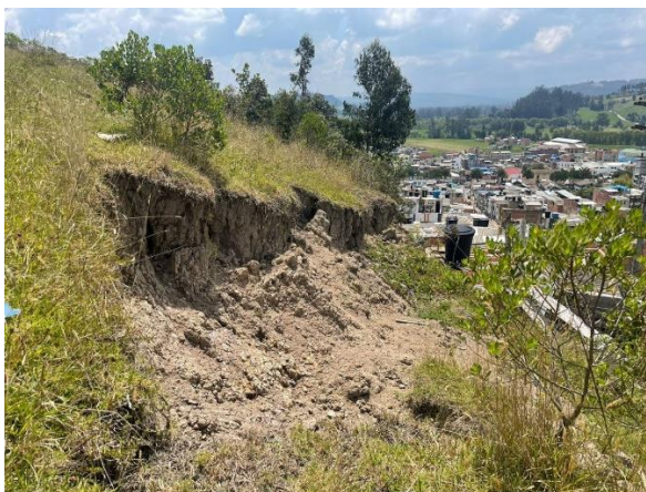
Ilustración 26 Talud en proceso de remoción Fuente: Propia
