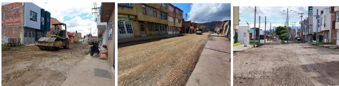
Ilustración 7 Compactación de material granular Barrio villa Gladys, Boyacá bajo y jardín del norte
