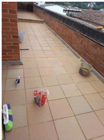
Ilustración 19 Fisura en la boquilla tono tabaco
