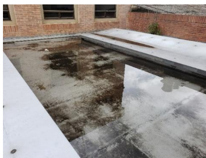
Ilustración 28 Prueba de estanqueidad Fuente: Propia
