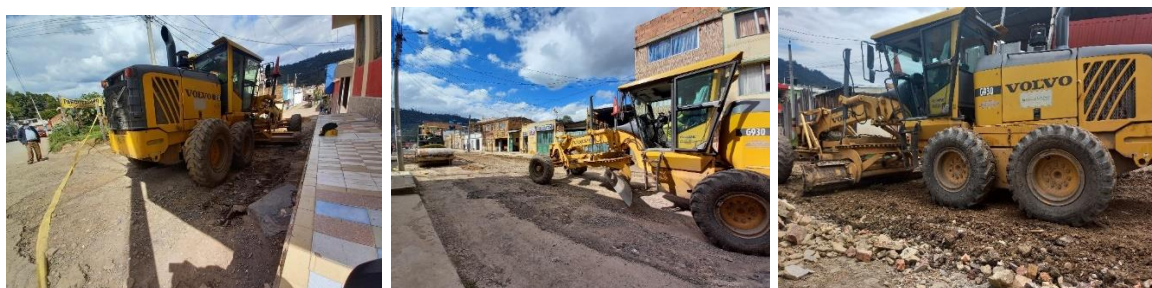
Ilustración 6 Nivelación de material Barrio villa Gladys, Boyacá alto y Boyacá bajo
