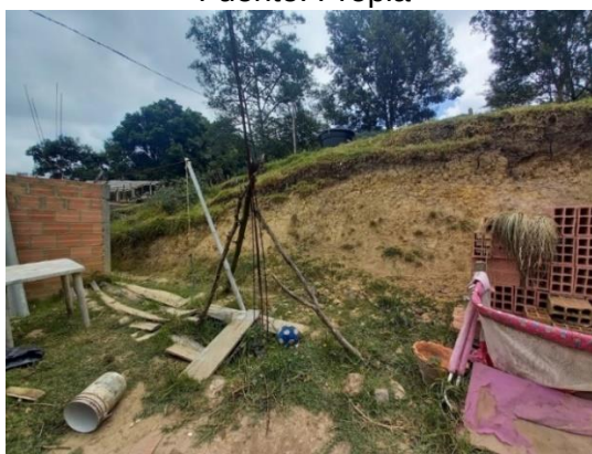
Ilustración 25 Talud en proceso de remoción Fuente: Propia
