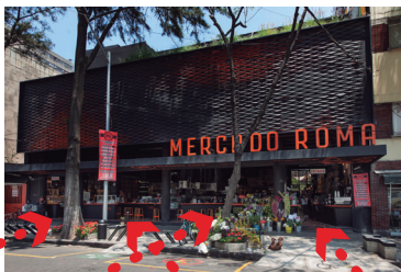
Figura 22: Fachada principal y accesos del edificio
