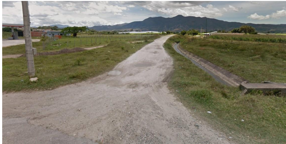
Figura 30. Vía del casco rural
