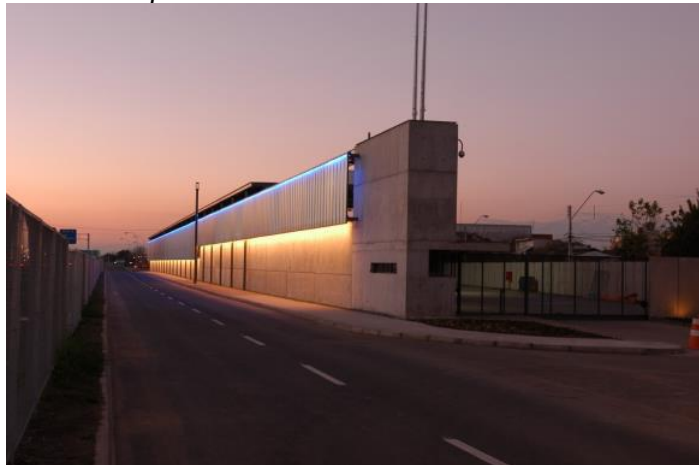
Figura 9. Fachada posterior del edificio
