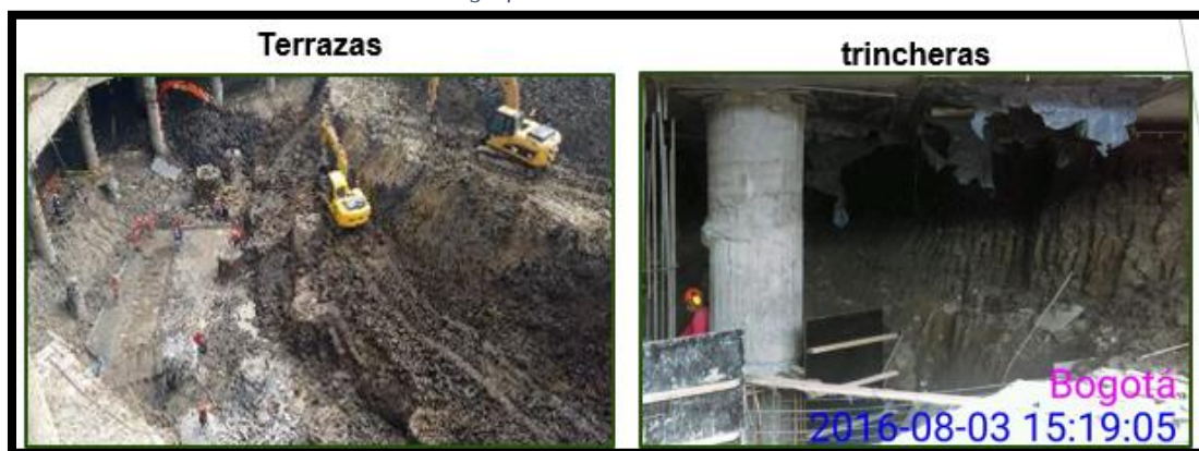
Fotografía 7 métodos de excavación.
