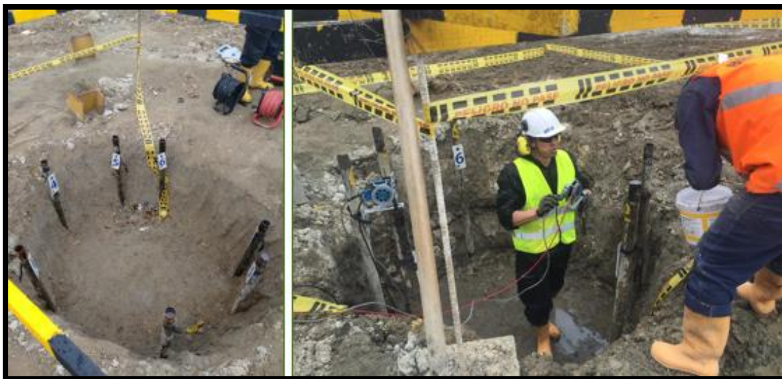
Fotografía 3 Prueba para integridad de pilotes
