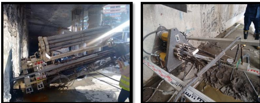
Fotografía 9 perforaciones para anclajes tieback.
