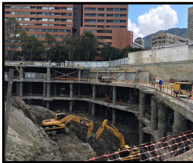
Fotografía 6 proceso de excavación.
