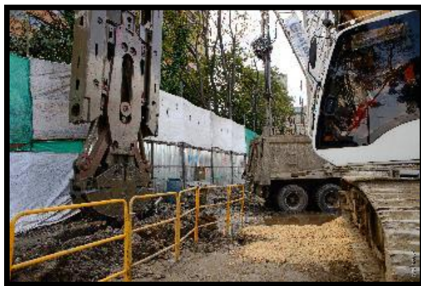
Fotografía 1 excavación muros pantalla
