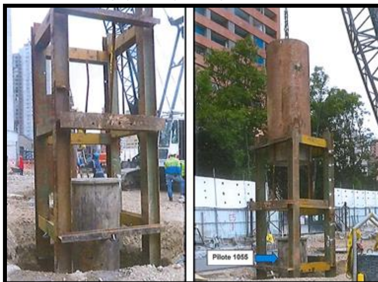
Fotografía 5 Ensayo de carga dinámica.
