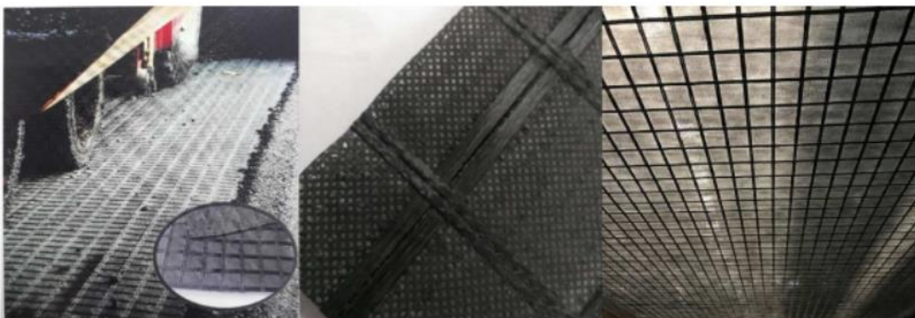
Figura 7.1. Imagen geomalla en el pavimento.
