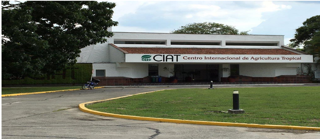
Figura 10. PA Entrada Fuente: Google imágenes
