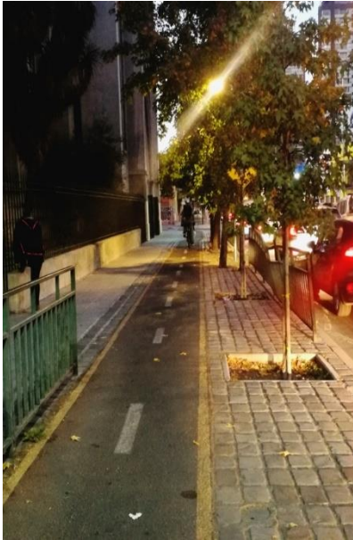
Ilustración 7.11 Poca visibilidad de señal vertical. Fuente: Elaboración propia.
