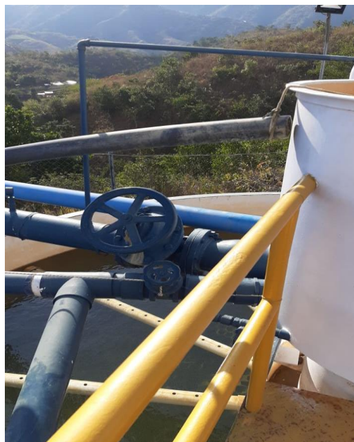
Figura 11. Barandas de la superficie del tanque clarificador. Información adaptada de la planta del acueducto de la empresa EMCAR A.P.C.
