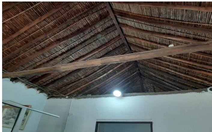
Figura 42. Cubierta (techo) de oficinas del área administrativa. Información adaptada del área administrativa de la empresa EMCAR A.P.C.
