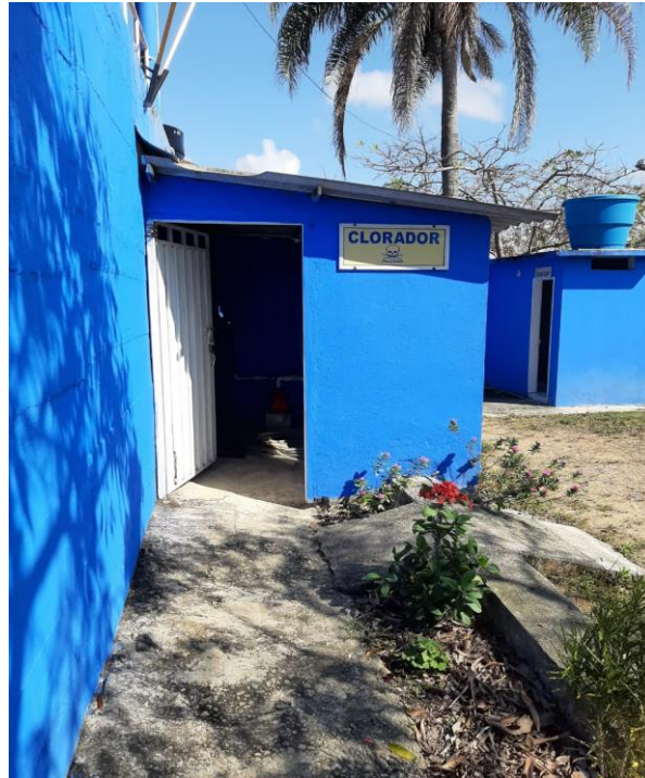
Figura 1. Almacén de clorador en la planta de tratamiento del agua de EMCAR A.P.C.
