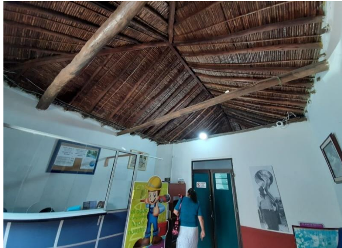
Figura 43. Cubierta (techo) de oficinas del área administrativa. Información adaptada del área administrativa de la empresa EMCAR A.P C.
