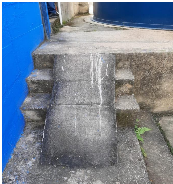
Figura 41. Rampla de la ruta del transporte de la carga. Información adaptada de la planta del acueducto de la empresa EMCAR A.P.C.
