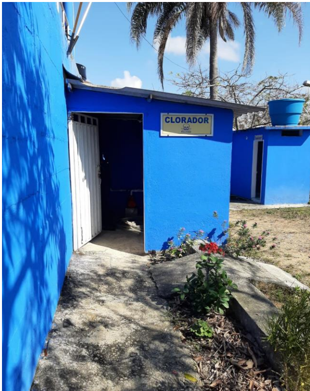
Figura 13. Almacén de clorador. Información adaptada de la planta del acueducto de la empresa EMCAR A.P.C.
