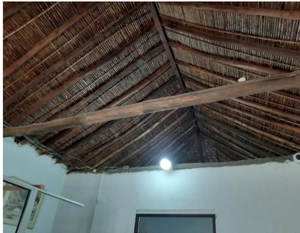
Figura 50. Cubierta (techo) de oficinas del área administrativa. Información adaptada del área administrativa de la empresa EMCAR A.P.C.
