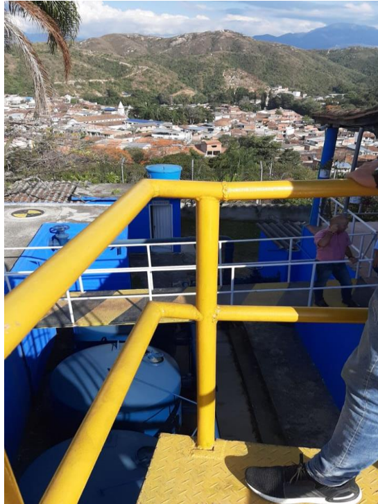
Figura 10. Barandas de la superficie del tanque clarificador. Información adaptada de la planta del acueducto de la empresa EMCAR A.P.C.
