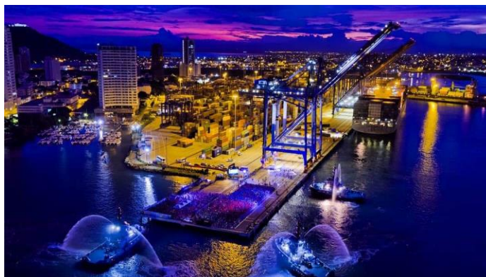
Ilustración 43 Vista Nocturna Del Puerto Y Su Edificio De Capacitación Y Administrativo
