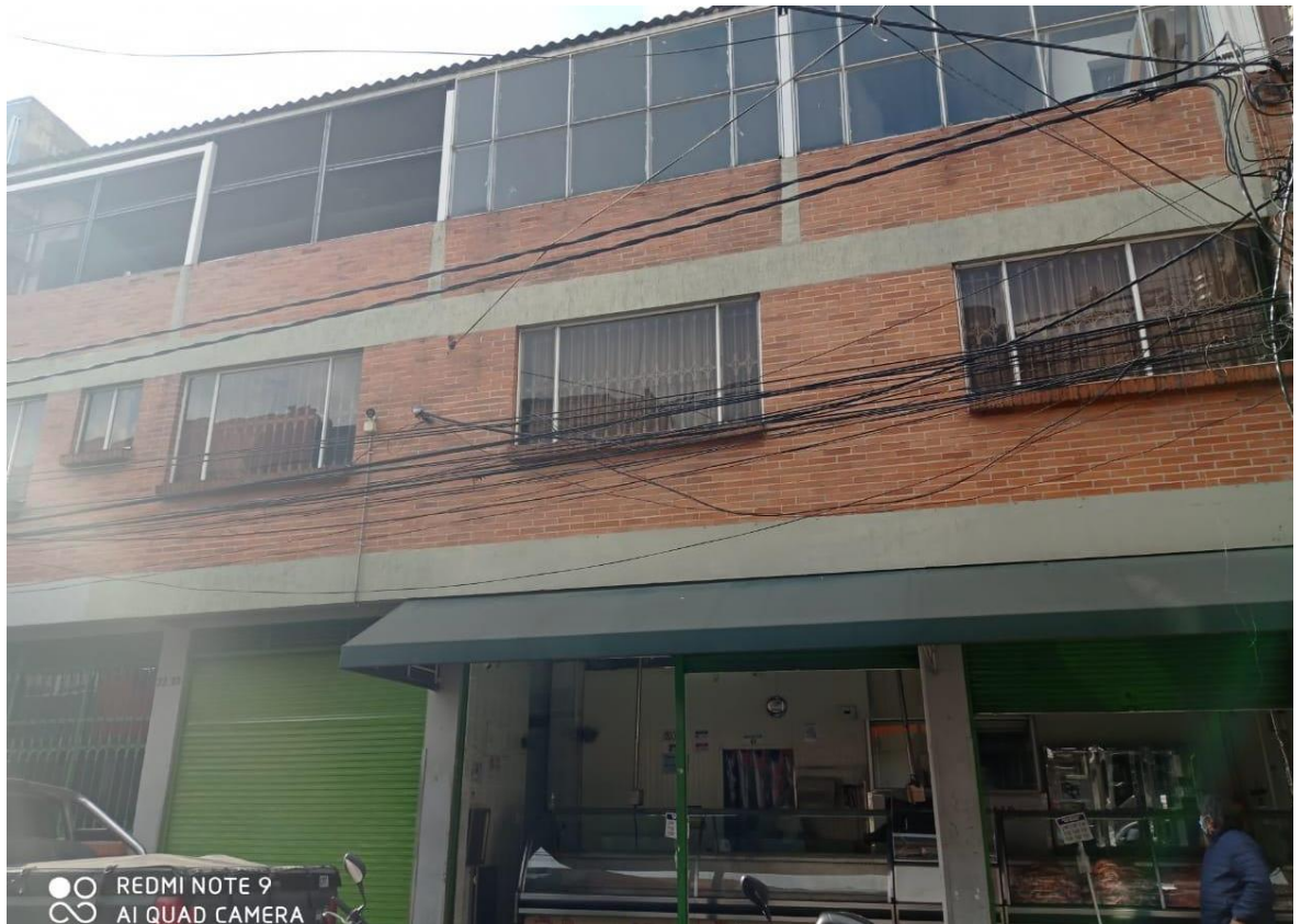
Imagen 2. Fotografía - Edificio Distribuidora LR Ltda.
