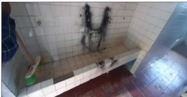
Figura 8. Registro fotográfico zona de lavamanos
