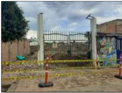
Figura 18. Registro fotográfico de obra
