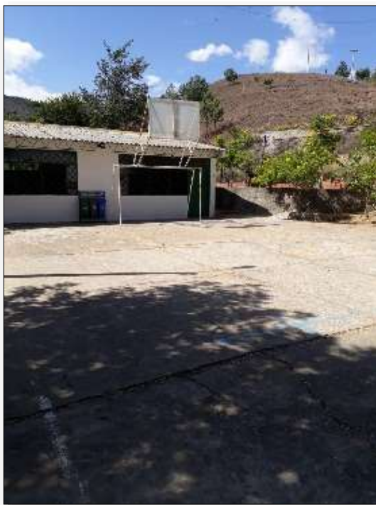
Figura 22 Evidencia fotográfica levantamiento de placas
