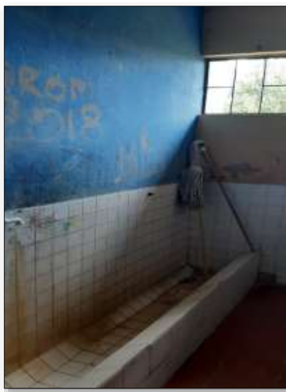
Figura 9. Registro fotográfico zona de orinales
