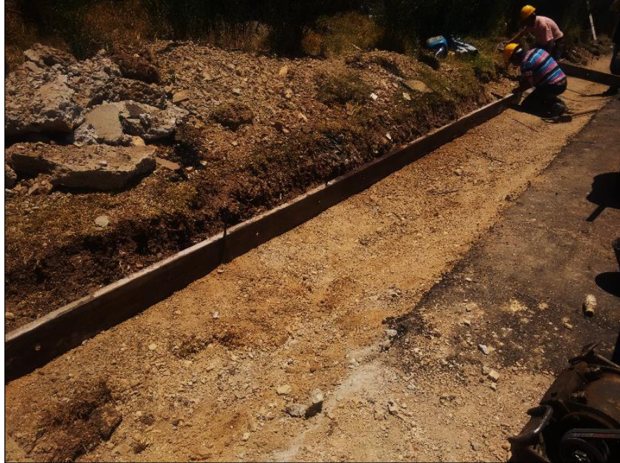
Imagen 20. Colocación de formaletas
