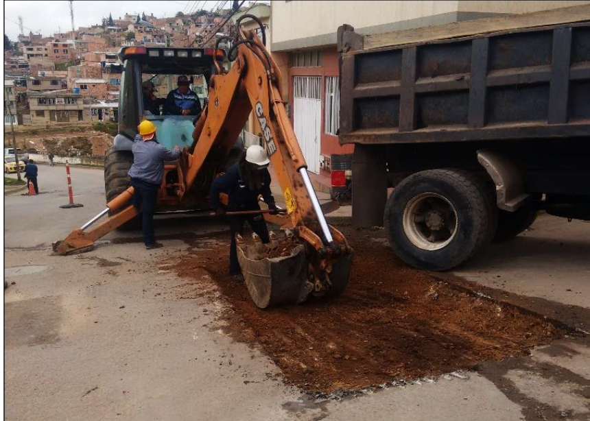
Imagen 9. Cargue, transporte, descargue y disposición de materiales excavados
