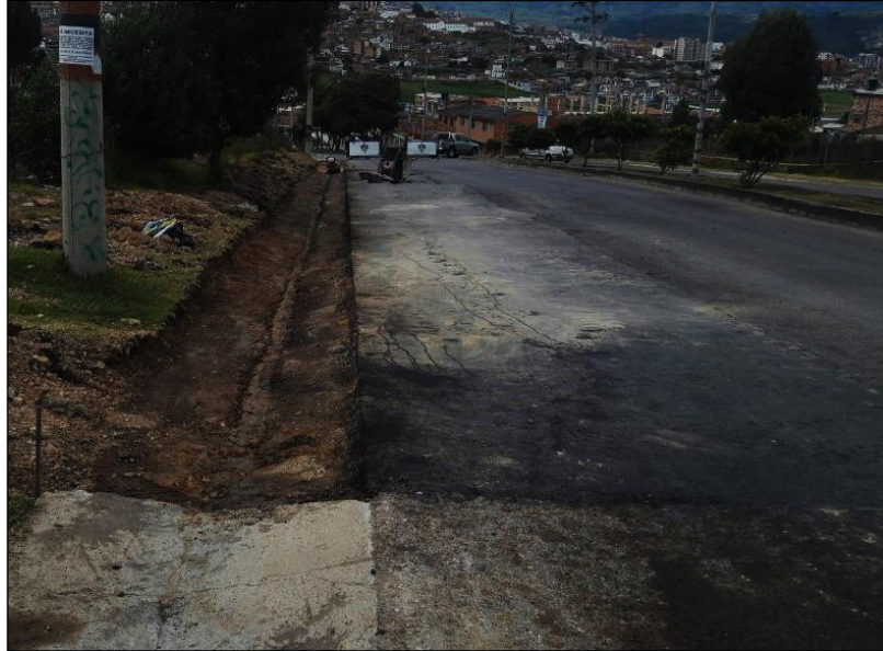
Imagen 18. Preparación de la cuneta en el material de soporte
