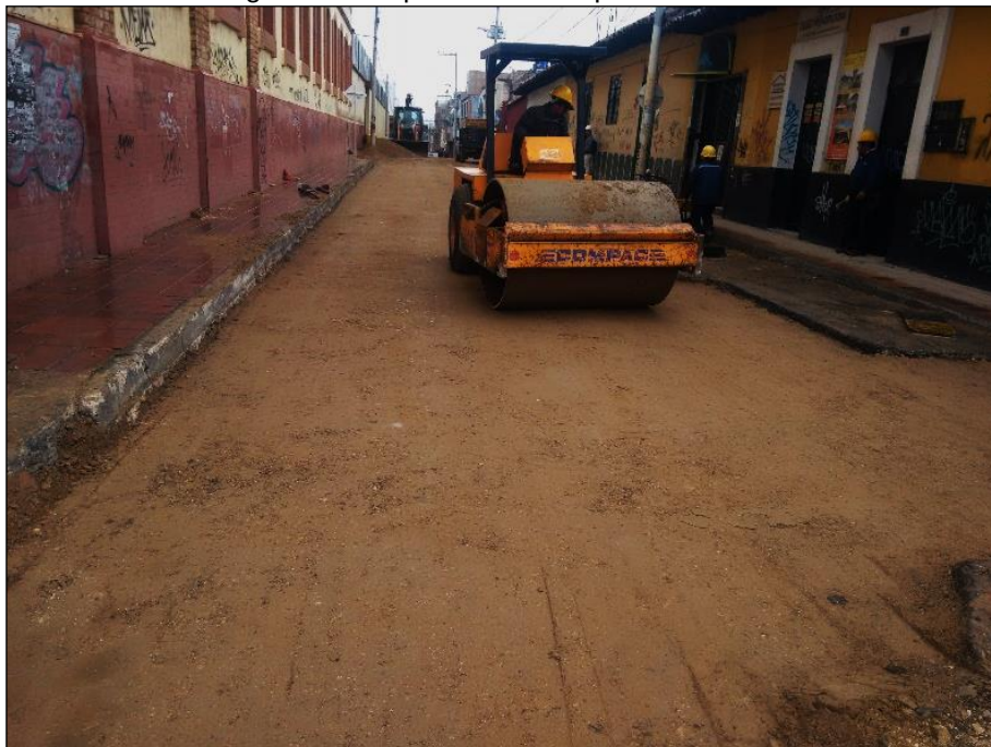
Imagen 10. Preparación de superficie existente
