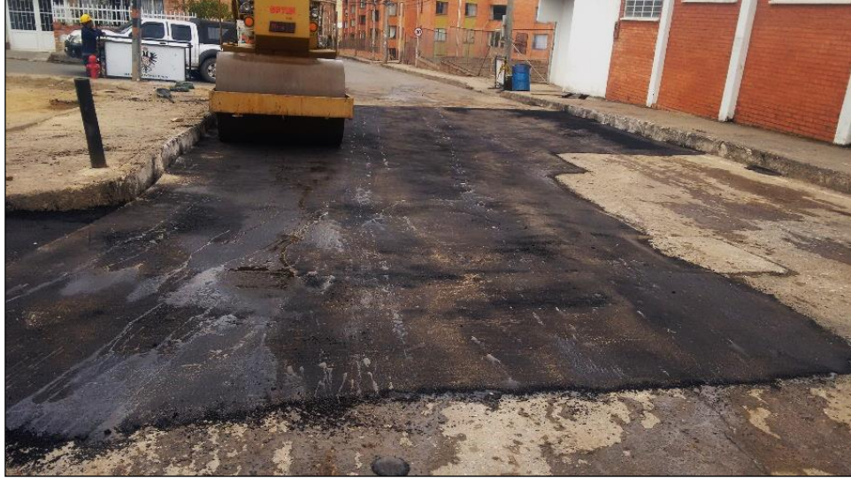
Imagen 16. Compactación sello de arena-asfalto
