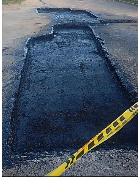
Imagen 11. Aplicación del ligante bituminoso y emulsión asfáltica de baches y parches
