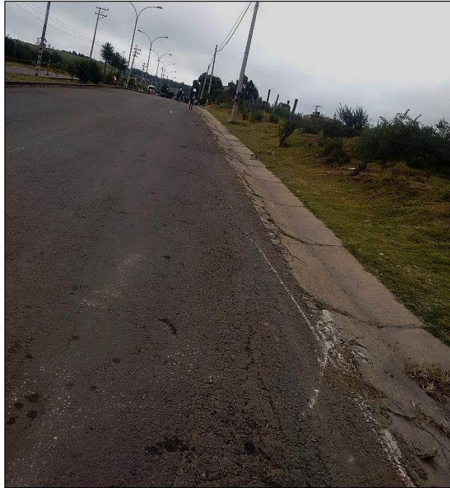
Imagen 17. Cunetas revestidas en concreto
