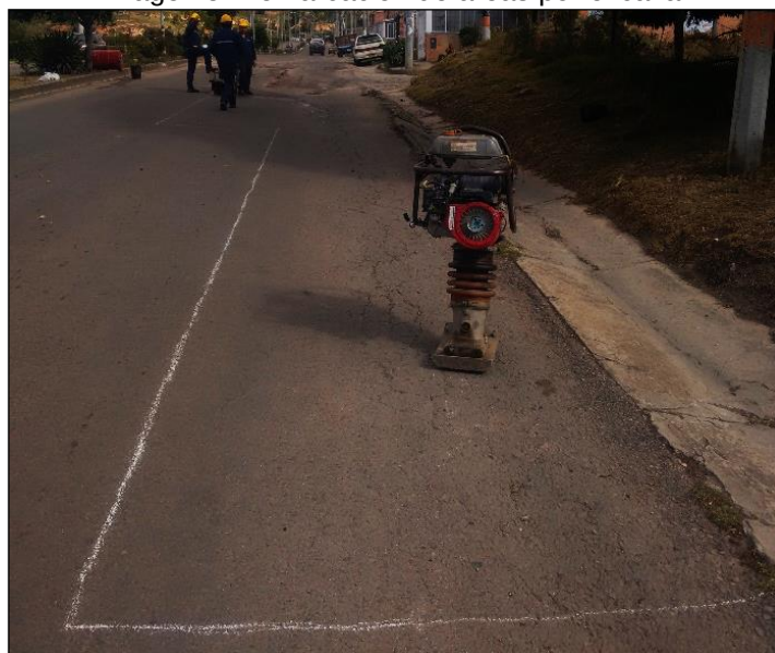
Imagen 5. Demarcación de áreas por excavar
