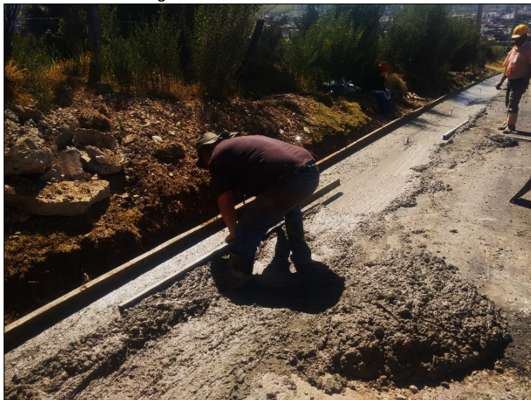
Imagen 21. Construcción de cuneta
