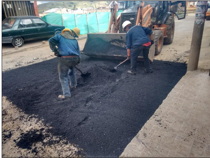
Imagen 15. Extensión de arena-asfalto
