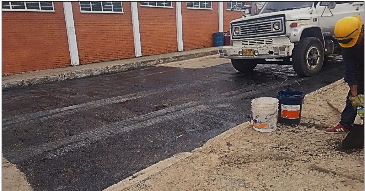
Imagen 14. Aplicación del ligante bituminoso y emulsión asfáltica
