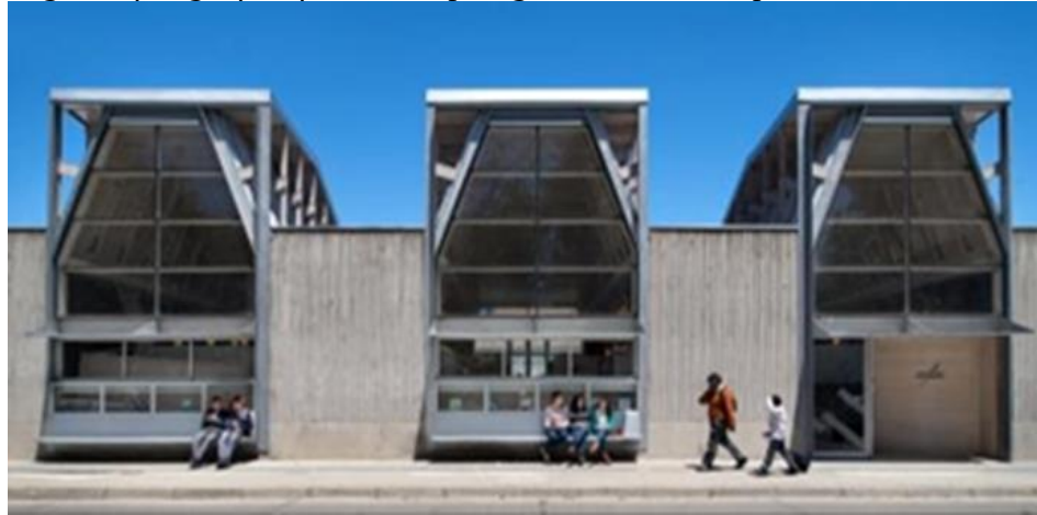
Figura 42. Registro fotográfico fachada. tipología 3. Biblioteca pública de constitución
