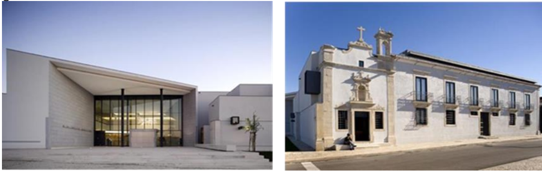
Figura 37. Registro fotográfico fachada. Tipología 2. Biblioteca municipal de Ílhavo/ARX Portugal
