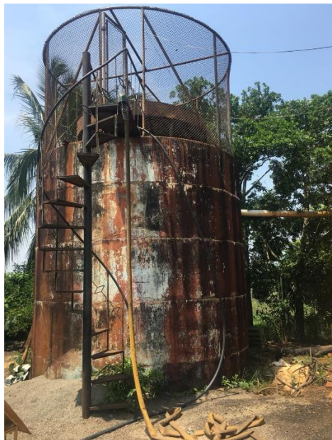
Figura 10. Sedimentador. Fuente: Autoría propia, 2019
