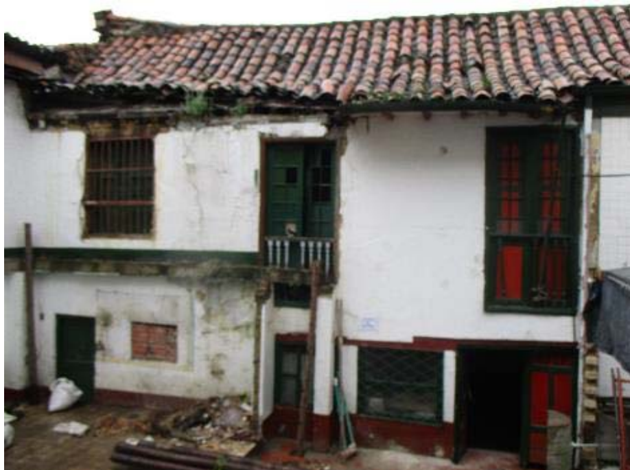
Ilustración 43 - Fachada posterior Edificación
