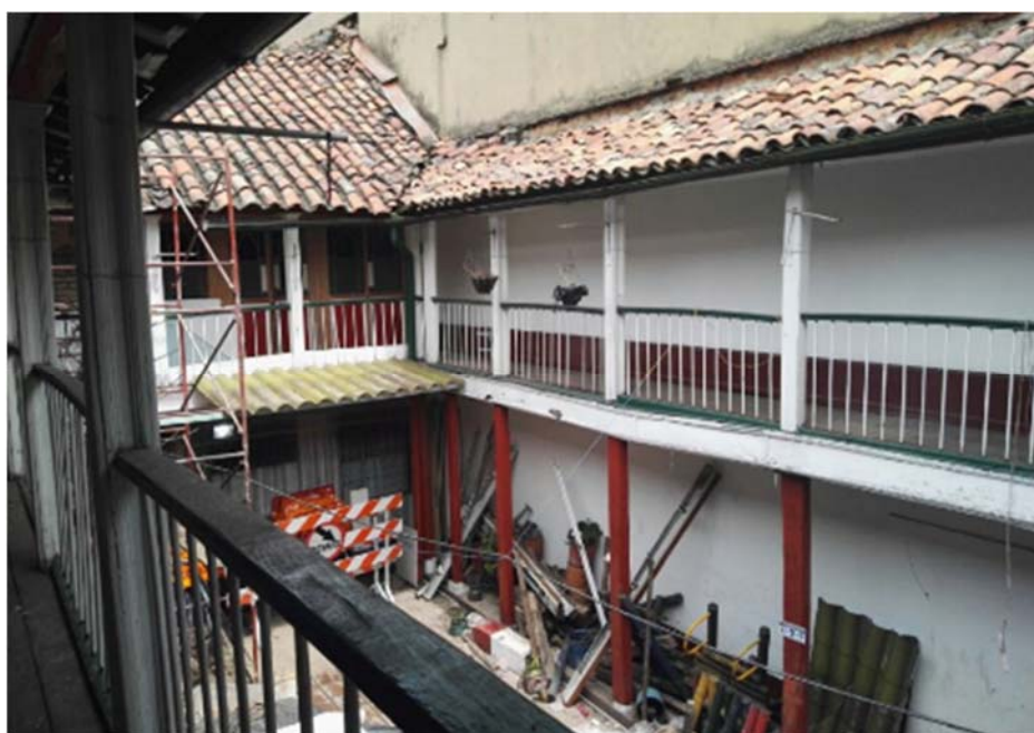
Ilustración 45 - Patio Interior edificación
