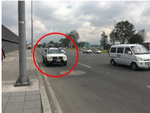
Imagen 84. Falta de señalización reglamentaria que prohíba parquear vehículos en el acceso principal al Aeropuerto El Dorado sentido Oriente - Occidente
