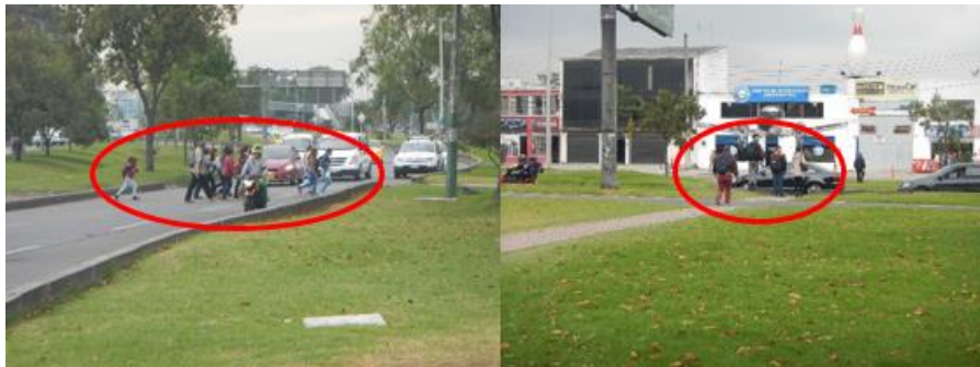
Imagen 61. Falta de paso a desnivel de peatones en la Carrera 100 sentido Occidente - Oriente
