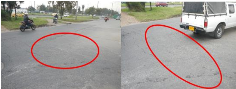
Imagen 46. Carencia de señales verticales y horizontales en la Carrera 96A.
