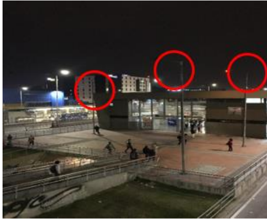
Imagen 31. Iluminación deficiente en puente peatonal del Portal El Dorado.
