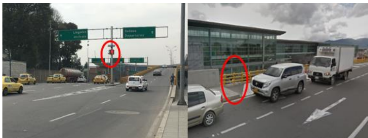
Imagen 85. Falta de señalización reglamentaria que prohíba el paso al peatón en el acceso principal al Aeropuerto El Dorado sentido Oriente - Occidente
