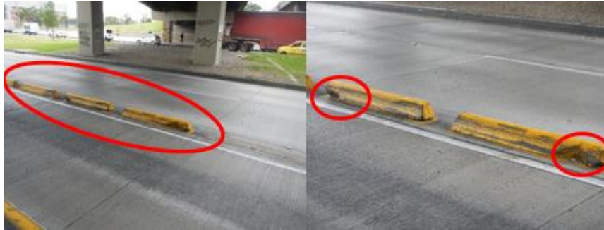
Imagen 25. Topes vehiculares horizontales debajo del puente de la Avenida Carrera 86.
