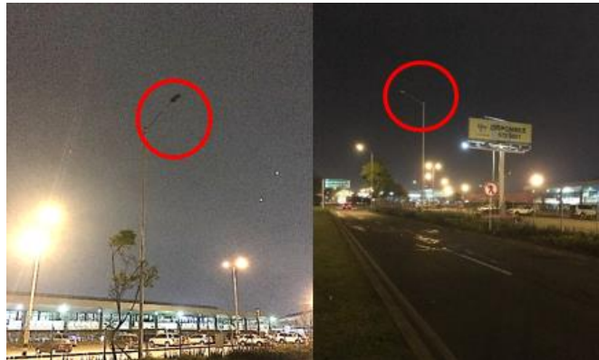
Imagen 79. Falta de iluminación en el corredor vial al frente del Puente Aéreo sentido Oriente - Occidente
