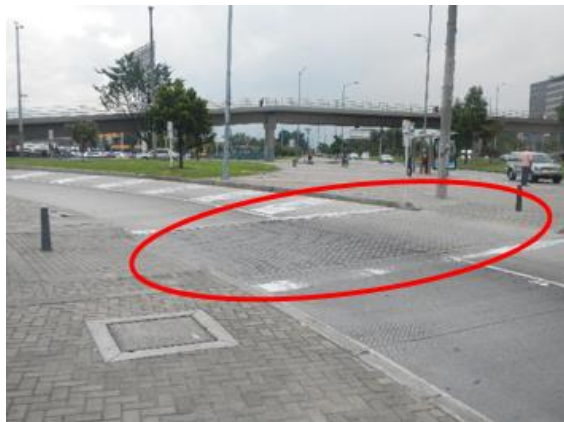
Imagen 20. Paso de peatones en la carrera 85K.
