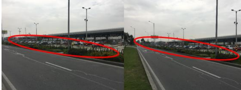
Imagen 78. Ausencia de accesos peatonales al frente del Puente Aéreo sentido Oriente - Occidente
