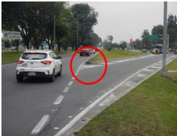
Imagen 73. Ausencia de demarcador doble en la Carrera 103 sentido Oriente – Occidente
