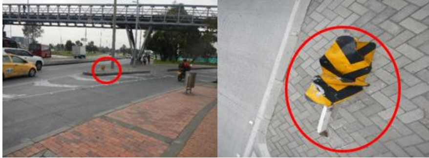
Imagen 43. Impacto en marcador doble de obstáculo en la Transversal 93.
