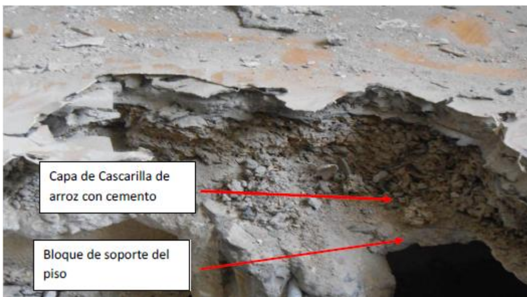
Detalle del sistema de Piso encontrado en los ensayos exploratorios.
