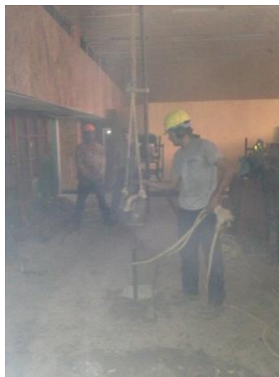
Imagen 21: Sondeo para estudio de geotécnico.
