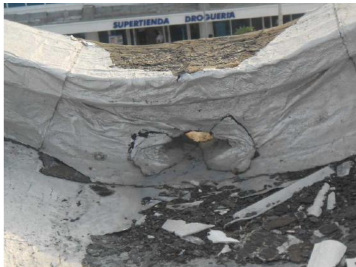
Imagen 16: Limpieza del sistema de desagüe
