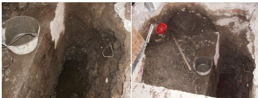
Exploración para determinar los espesores de las zapatas Columna-5C.
