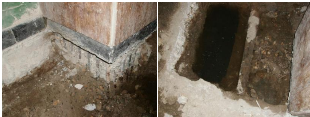
Exploración de la zapata de la Columna-2B, vecina a registro y tubería de aguas negras.
