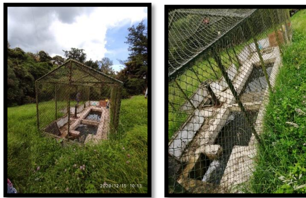
Imagen N°29 y 30. Vista general Desarenador.
