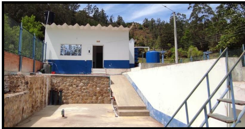
Imagen N°54. Caseta de Almacenaje.
