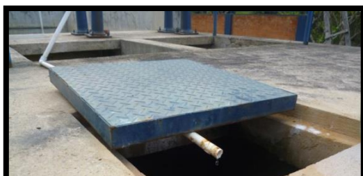
Imagen N°52 y 53. .Sistema de Dosificación de Hipoclorito de Calcio.
