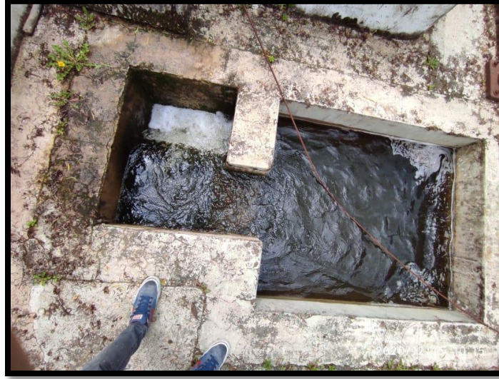
Imagen N°31. Caja de entrada desarenador.
