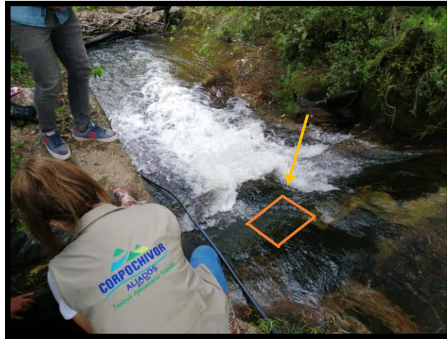
Imagen N°23. Rejilla de captación.
