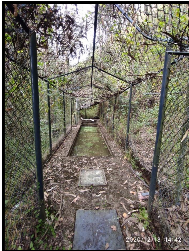
Imagen N°16. Desarenador.
