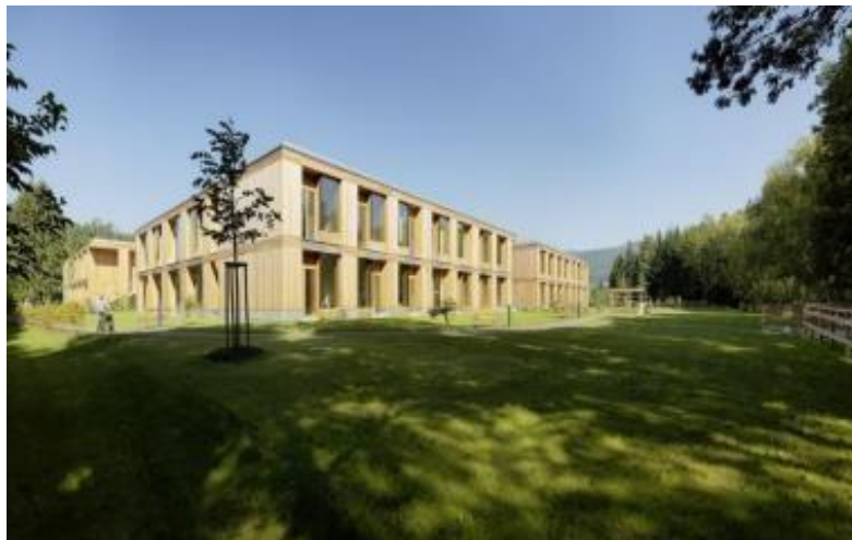
Figura 20 Vista exterior residencia
