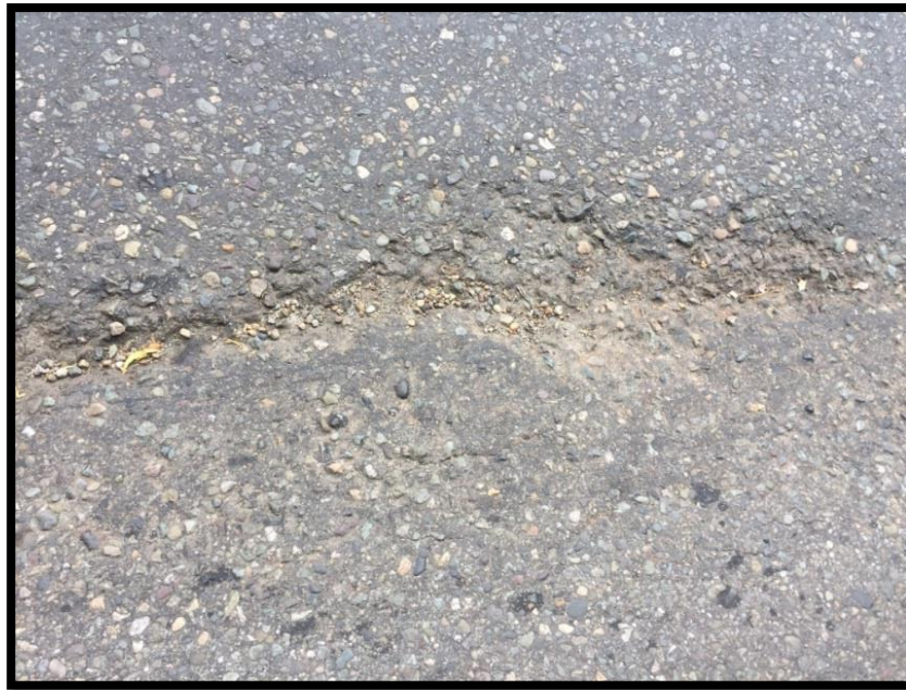
Figura 11-9 Descascaramiento (DC)
