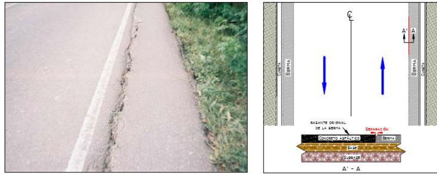
Figura 6-20 Separación de berma (SB, Unidad de medida: longitud).
