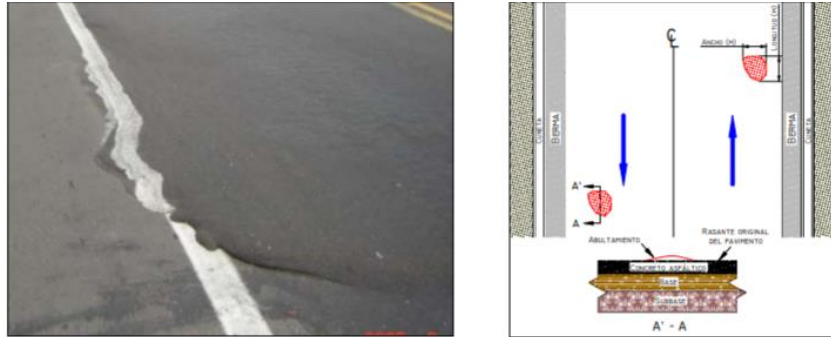
Figura 6-10 Abultamiento (AB, unidad de medida: m 2 ). Fuente: [2].
