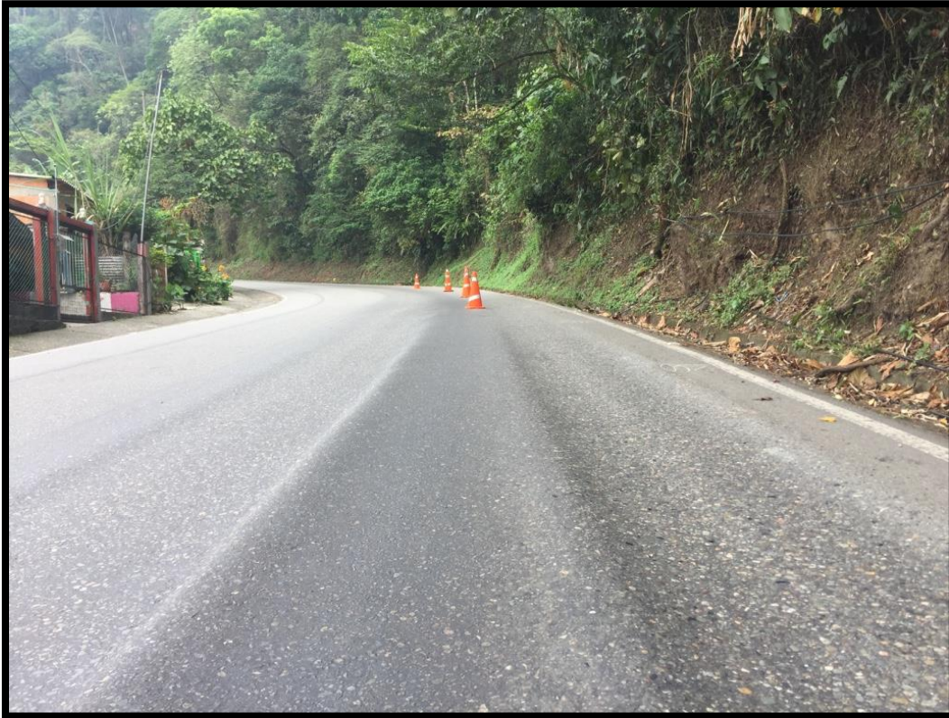
Figura 9-2 Zona de la inspección visual.
