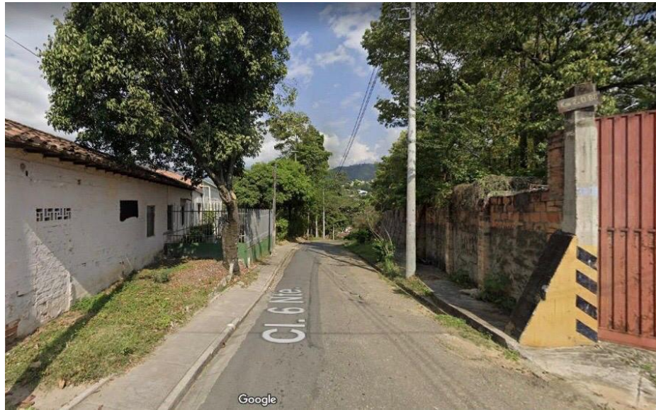
Figura 30. Vista de la Calle 6 Norte
