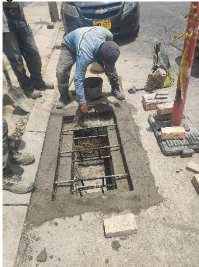
Figura 18 Instalación sumidero
