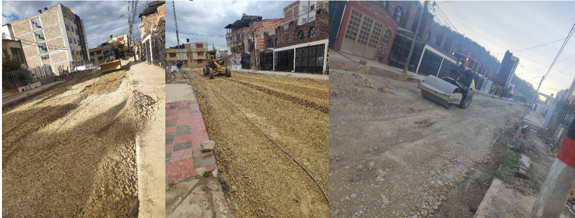
Figura 11 Conformación sub base
