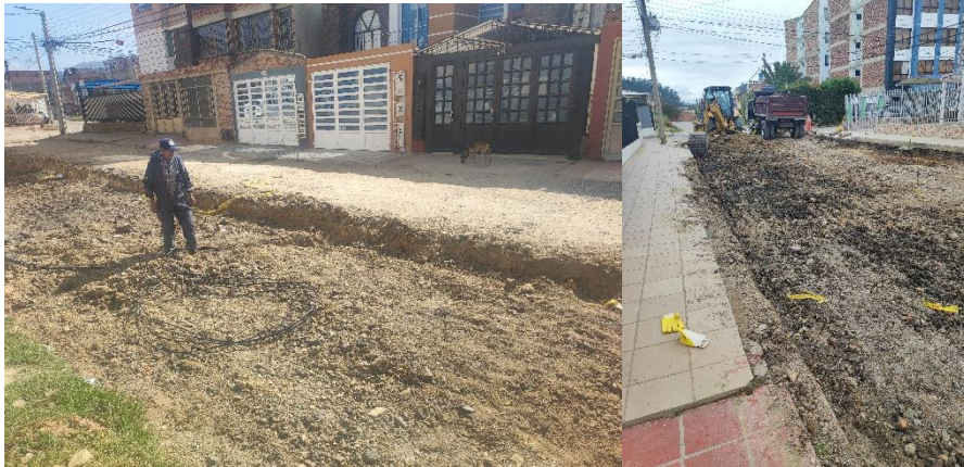
Figura 8 Excavación hasta subrasante
