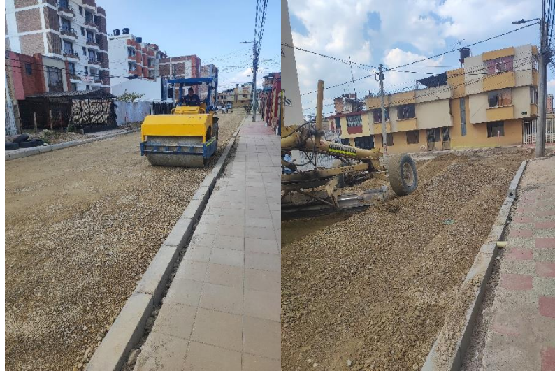
Figura 12 Conformación base
