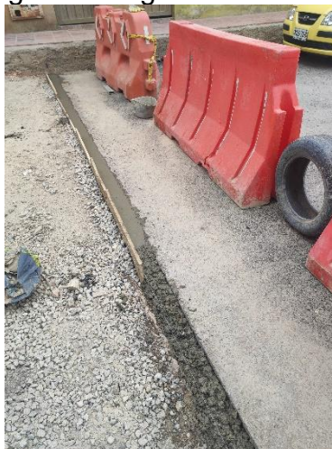
Figura 19 Viga confinamiento
