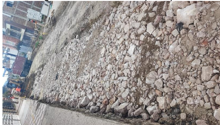
Figura 10 Conformación pedraplén
