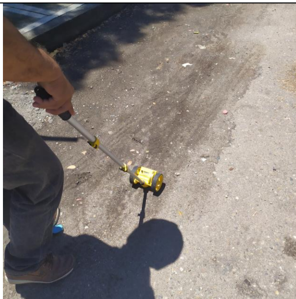
Foto N° 6. Desprendimiento del borde con nivel de severidad medio, encontrado en el tramo K0+000 – K0+0100. Sentido Espinal – Coello.
