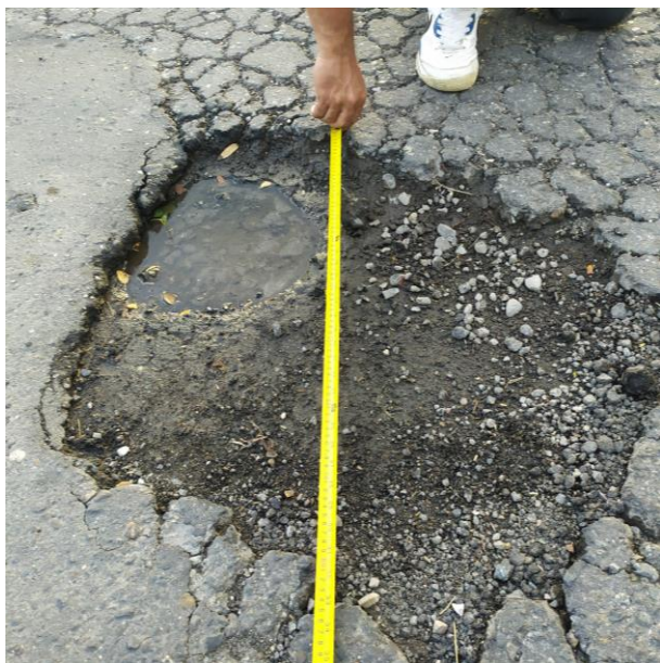
Foto N° 45. Ojo de pescado generado como evolución de FPC encontrado en el tramo K0+0500 – K0+0600. Sentido Coello -Espinal.
