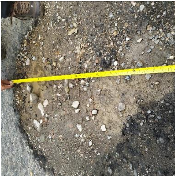
Foto N° 25. Ojo de pescado con alto grado de severidad encontrado en el tramo K0+0200 – K0+0300. Sentido Coello -Espinal.
