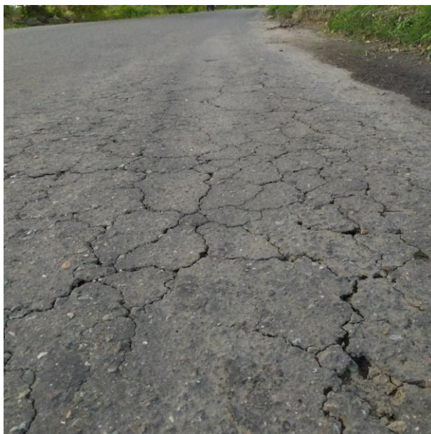
Foto N° 57. Fisuras piel de cocodrilo, encontrado en el tramo K0+0700 – K0+0800. Sentido Coello -Espinal.
