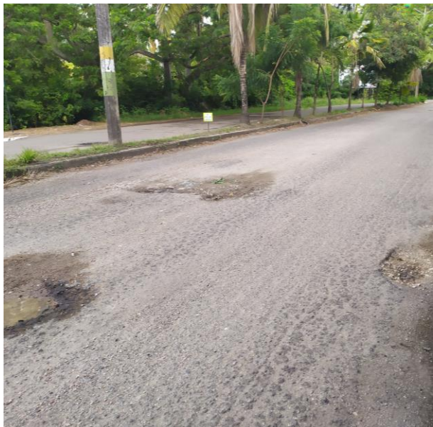
Foto N° 17. Primeros 35 metros del tramo K0+0100 – K0+0200. Sentido Coello -Espinal.
