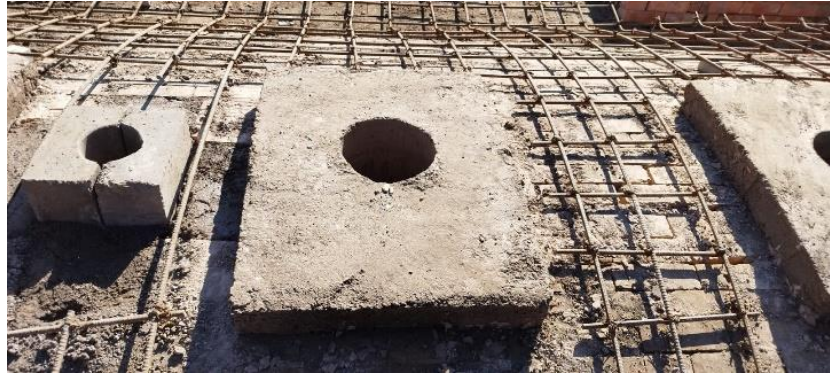
Imagen 11 fundición de piezas en concrax tipo 1300
