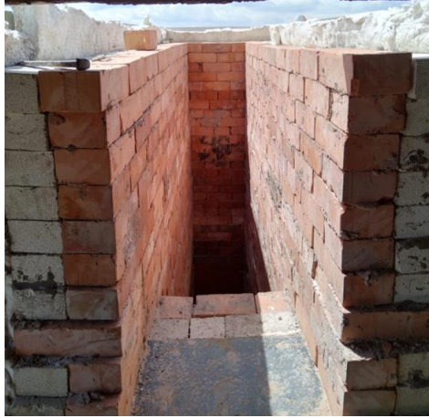
Imagen 32 instalación de mampostería para cajas de aire
