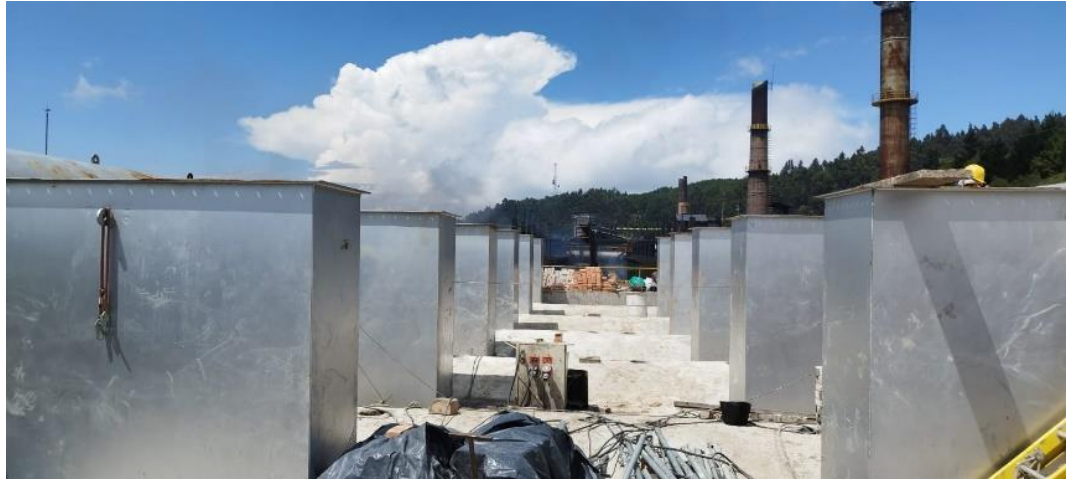
Imagen 30 cámaras de aire para hornos tipo solera
