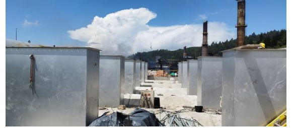
Imagen 38 finalización de cupulas con recubrimiento en concreto y estructura metálica
