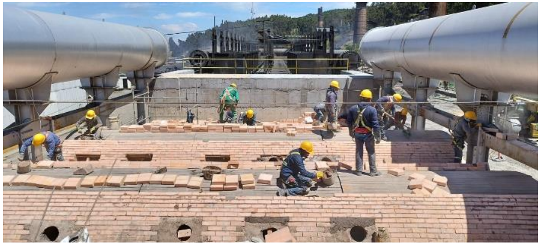
Imagen 9 Armado cupulas Hornos solera
