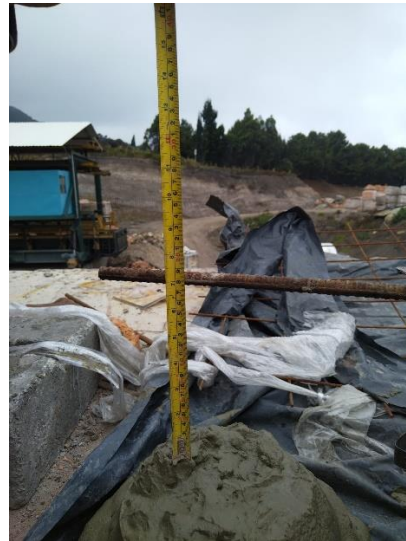
Imagen 39 determinación de asentamiento del concreto
