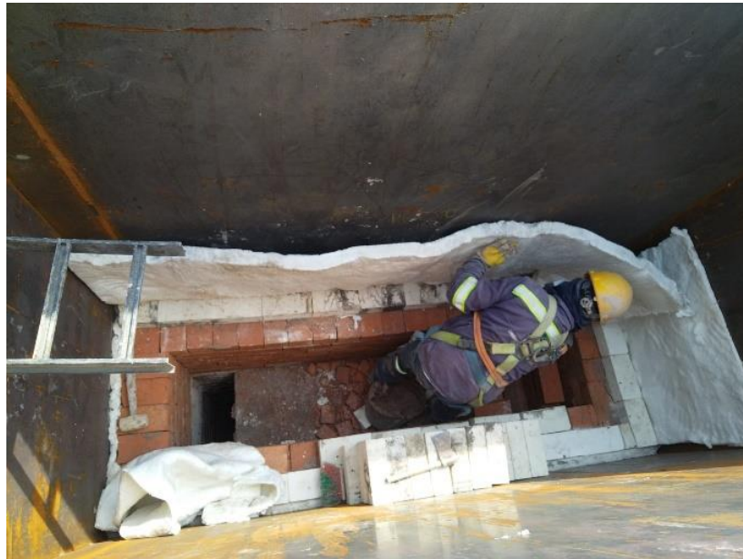
Imagen 31 instalación mampostería para cajas de aire
