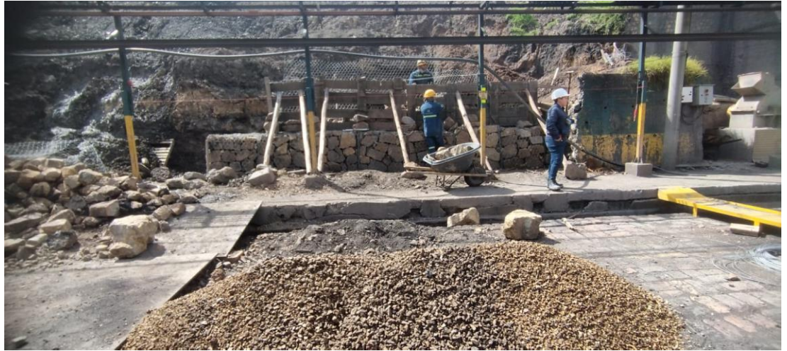
Imagen 34 Armado de muro en gaviones
