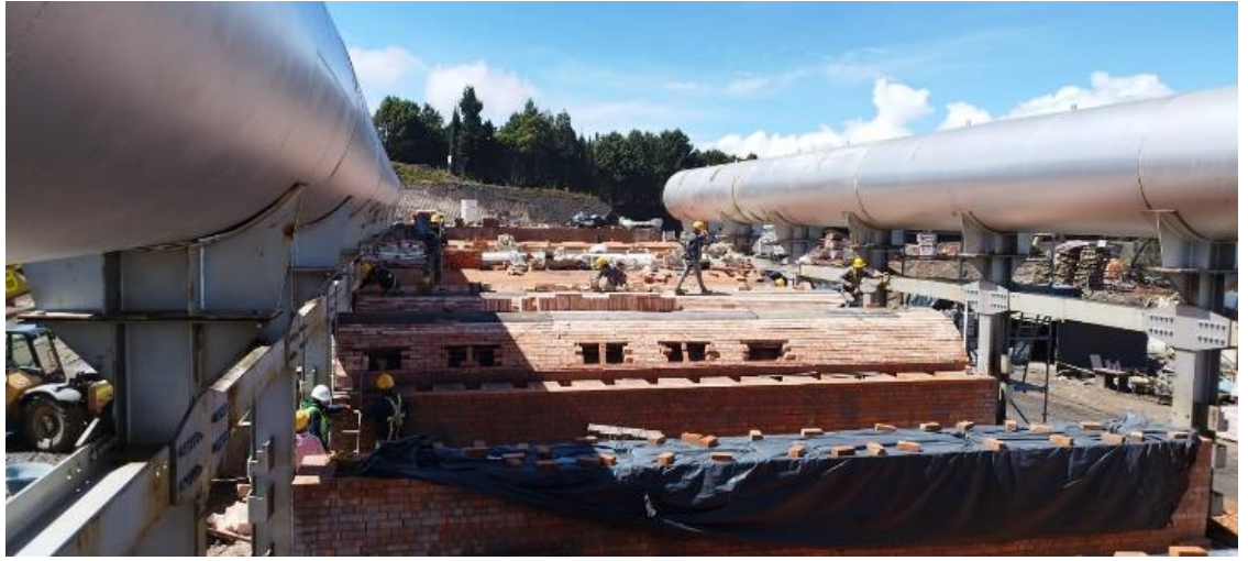
Imagen 8 Armado cupulas hornos solera
