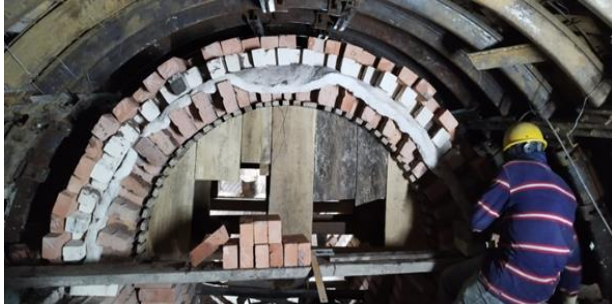
Imagen 23 instalación de cupulas en ducto subterráneo
