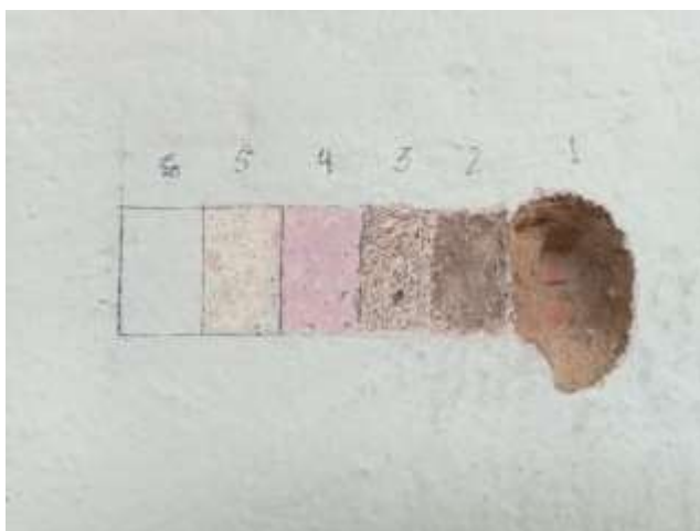
Figura 38. Cala para determinar materialidad y conformación de los muros. Fuente: Propia
