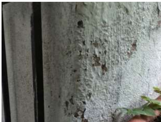
Figura 12 y 13. Lesiones de abombamientos y desprendimientos en los muros. Fuente: Propia
