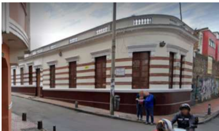
Figura 4. Fachada Casa CADEL en febrero 2020. Fuente: Google Maps Street view
