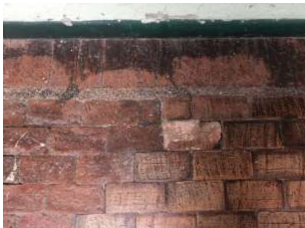
Figura 16 y 17. Lesiones de erosión mecánica y fractura en los pisos. Fuente: Propia
