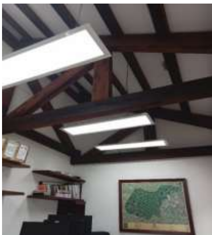
Muestra de estructura de cubierta en madera robusta con uniones en caja o alternativa con uniones con platinas y/o pernos
