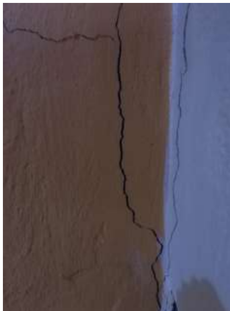
Figura 10 y 11. Lesiones de abombamientos y fisuras en los muros. Fuente: Propia
