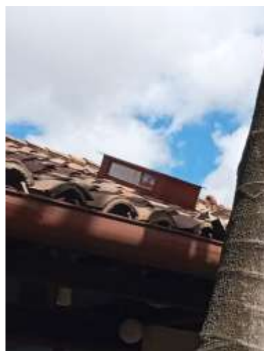
Muestra de lucarna o claraboya que permite el ingreso de iluminación cenital y salida de aire caliente evitando la humedad por condensación en los espacios de la edificación
