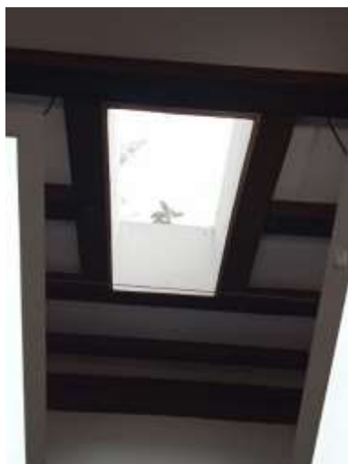
Muestra de lucarna o claraboya que permite el ingreso de iluminación cenital y salida de aire caliente evitando la humedad por condensación en los espacios de la edificación
