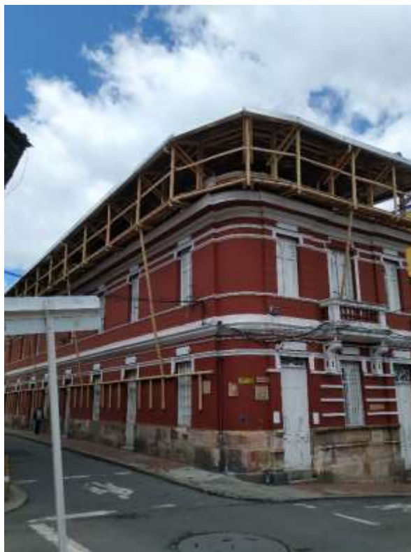
Figura 1. Fachada Casa Colorada. Fuente: Autor
