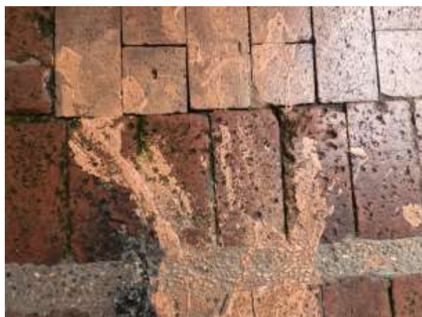
Figura 18 y 19. Lesiones de tipo antrópico por mal mantenimiento en los pisos. Fuente: Propia
