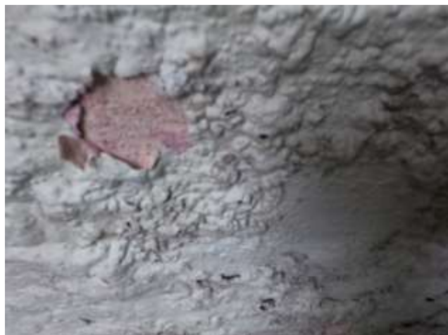
Figura 12 y 13. Lesiones de abombamientos y desprendimientos en los muros. Fuente: Propia
