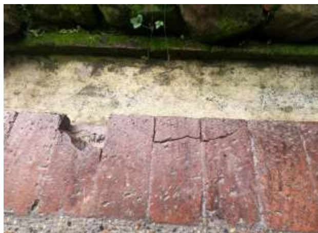
Figura 16 y 17. Lesiones de erosión mecánica y fractura en los pisos. Fuente: Propia
