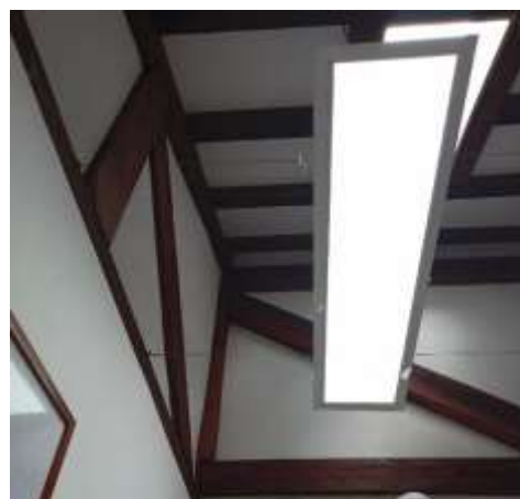
Muestra de estructura de cubierta en madera robusta con uniones en caja o alternativa con uniones con platinas y/o pernos
