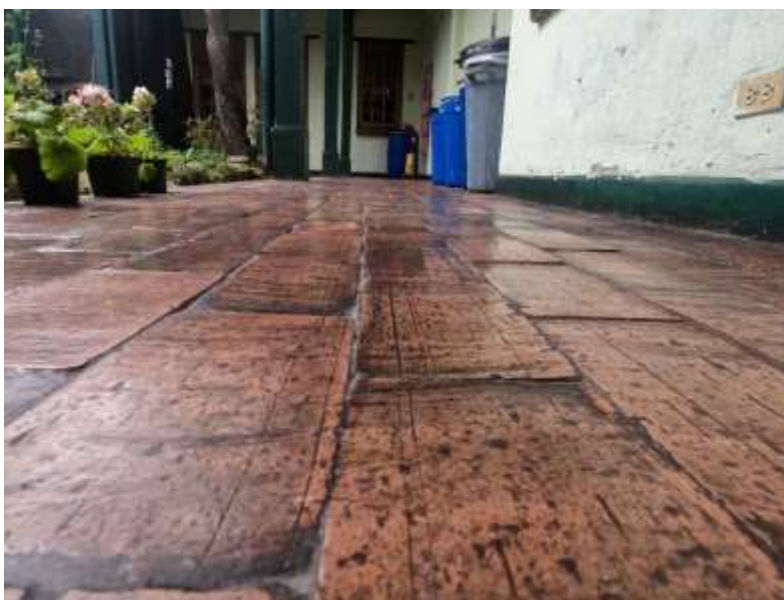
Figura 7. Estado actual de la edificación año 2022. Fuente: Propia
