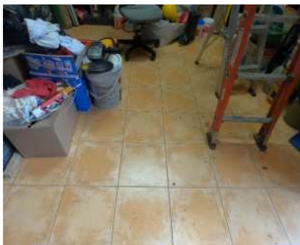
Figura 20 y 21. Lesiones de tipo antrópico por diseño con material inadecuado en los pisos. Fuente: Propia
