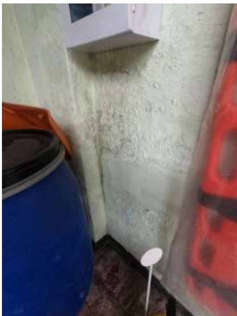
Figura 10 y 11. Lesiones de abombamientos y fisuras en los muros. Fuente: Propia
