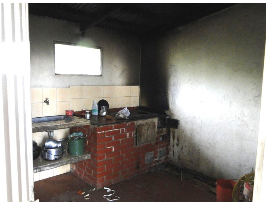
COCINA CASA CAMPAMENTO – BODEGA
