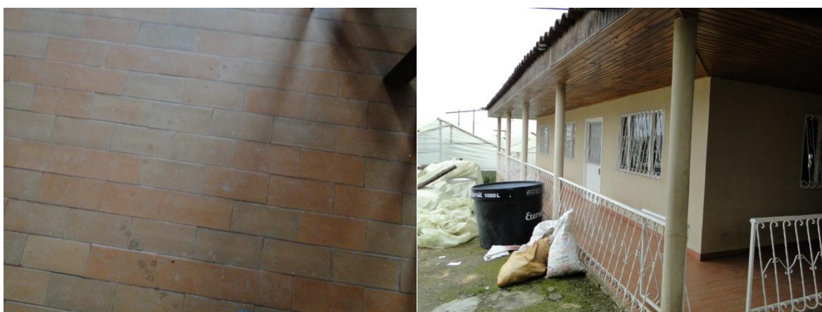
PISOS, REJA METALICA CERRAMIENTO Y CIELO RASO CASA PRINCIPAL
