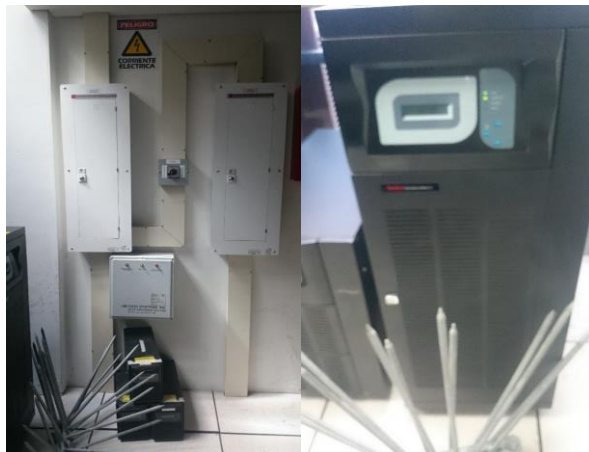
Figura 45. Sistema eléctrico y de respaldo
