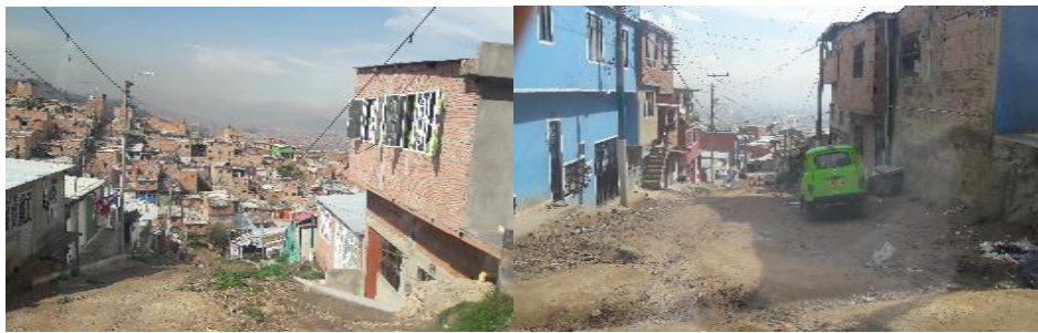
Figura 27. Estado de vías Altos de Cazucá.
