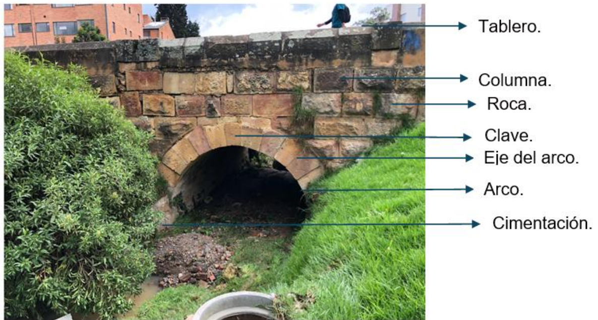
Figura 4. Partes del puente Pinzón.
