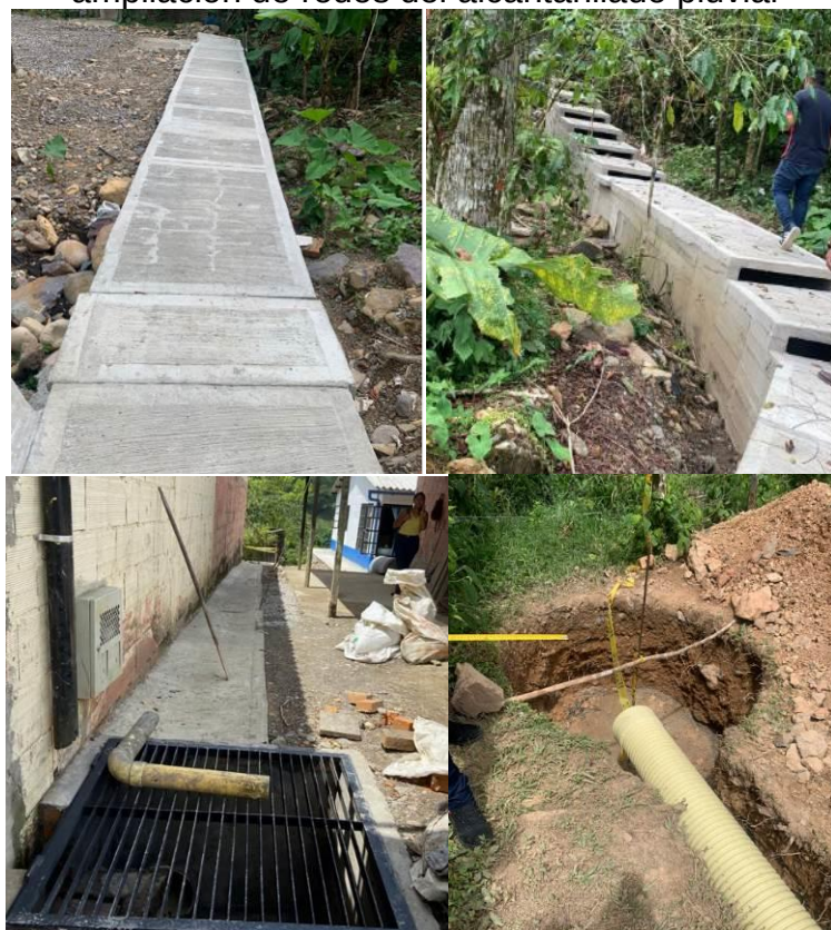
Figura 33. Visita de obra al contrato de construcción, mejoramiento, optimización y ampliación de redes del alcantarillado pluvial
