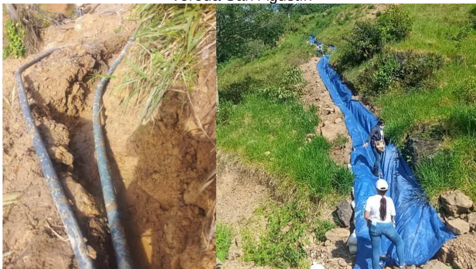
Figura 34. Visita de obra al contrato de manejo de aguas de escorrentía en la vereda San Agustín
