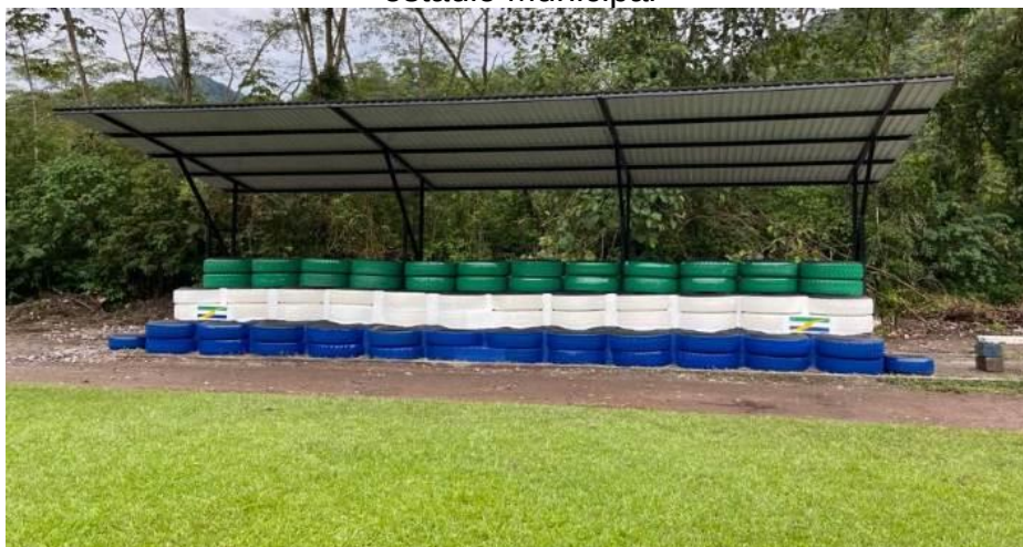
Figura 31. Visita de obra para recibir contrato de mejoramiento y optimización del estadio Municipal
