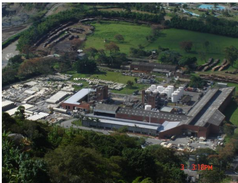
Ilustración 4: Instalación industrial Andercol Barbosa
