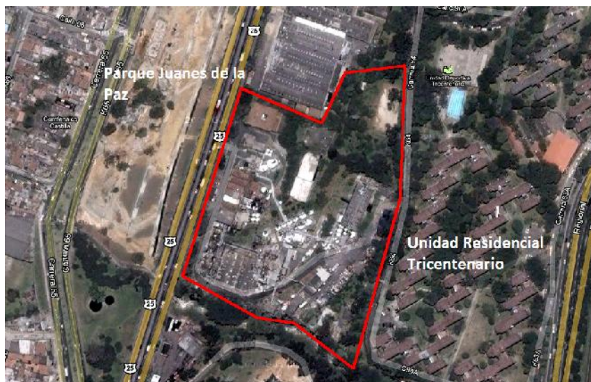
Ilustración 3: Instalación industrial Andercol Medellín
