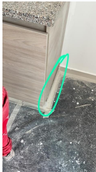
Proyecto Arboleda Campestre 4 Supervisión de acabados Fuente: Propia
