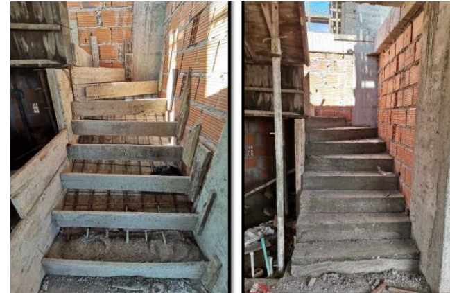
Proyecto Arboleda Campestre 4 Supervisión de fundición de Escalera Fuente: Propia
