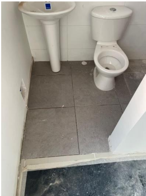
Proyecto Arboleda Campestre 4 Supervisión Puesta de Enchapes Fuente: Propia
