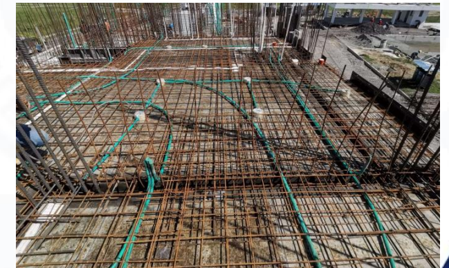
Proyecto Arboleda Campestre 4 Supervisión de Instalaciones Eléctricas Fuente: Propia
