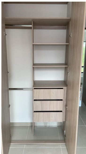
Proyecto Arboleda Campestre 4 Supervisión Carpintería de las Casas Fuente: Propia
