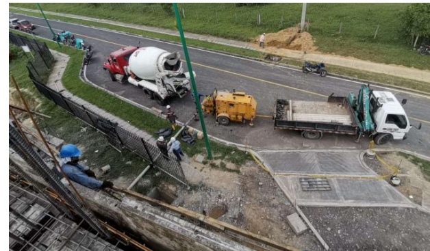
Proyecto Arboleda Campestre 4 Supervisión de Concreto Fuente: Propia
