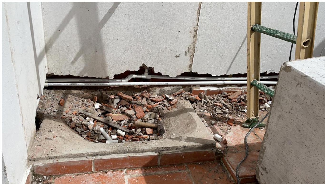
Proyecto Arboleda Campestre 4 Supervisión arreglo fuga de agua Fuente: Propia
